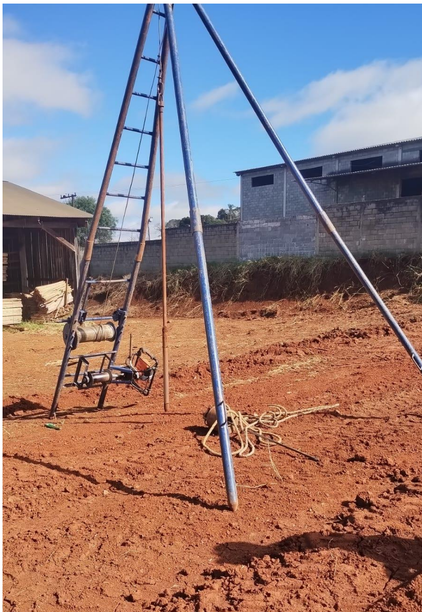
Figura 4 - Levantamento em campo - SPT 02, fonte: do autor, 2025.
