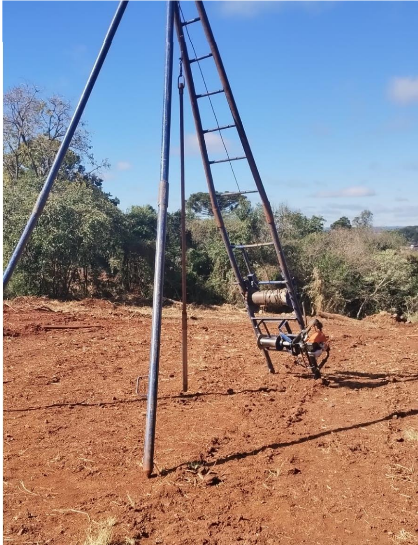
Figura 5 – Levantamento em campo – SPT 03, fonte: do autor, 2025.
