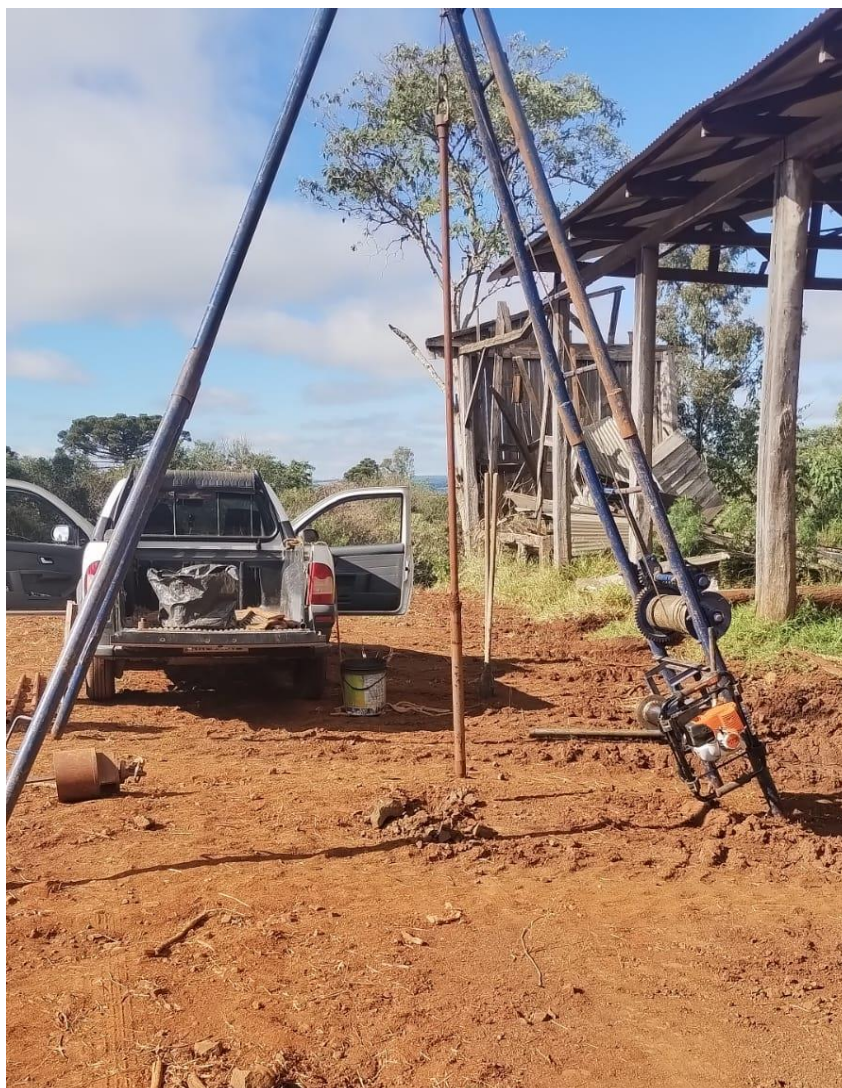
Figura 3 – Levantamento em campo – SPT 01, fonte: do autor, 2025.
