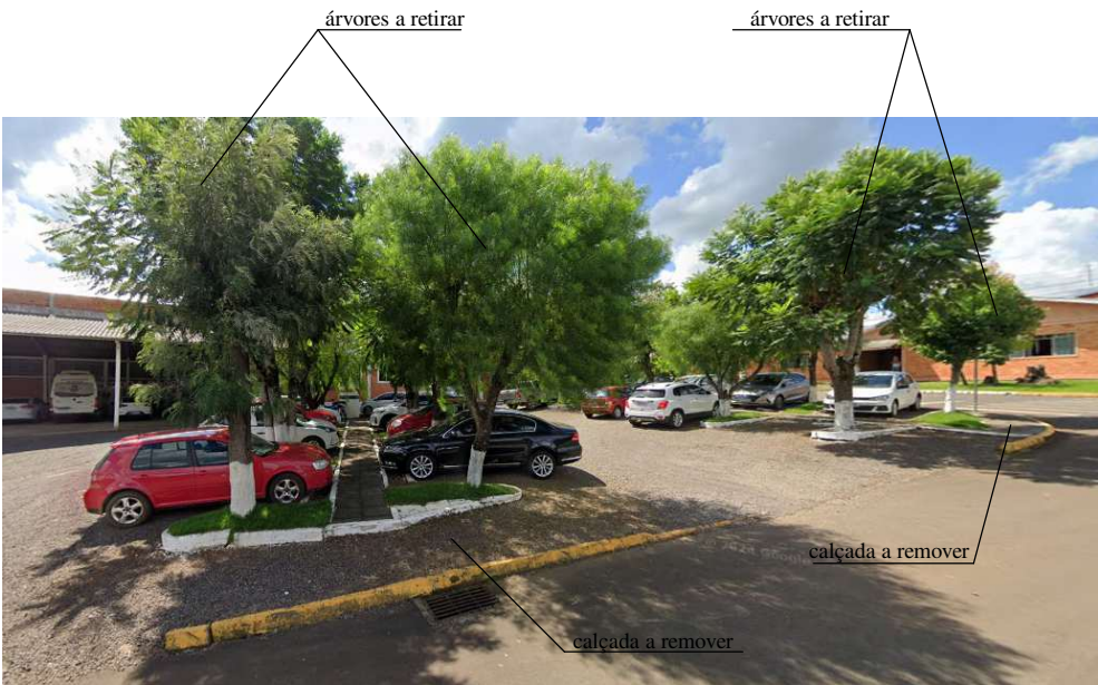
Vista dos elementos a demolir/remover
