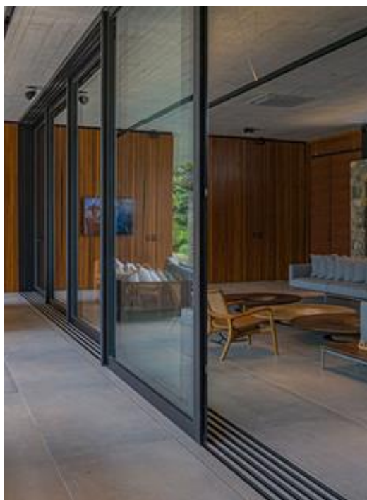
Figura 5 – Porta-Janela de alumínio.
