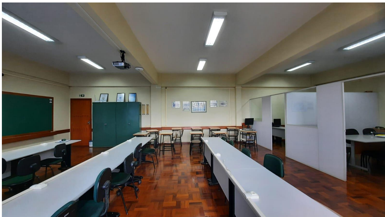
Figura 4 – Imagem da Sala B201 antes da elaboração do projeto de reforma e adequação.
