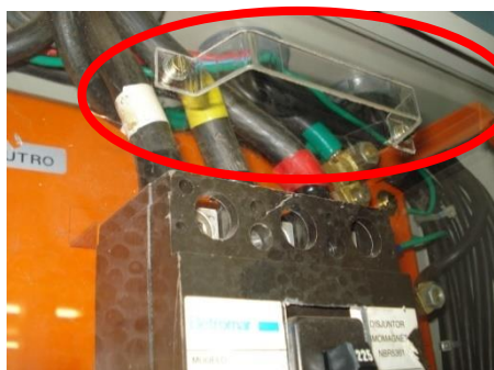
Figura 4 – Pegador de acrílico da tampa do quadro de distribuição.
