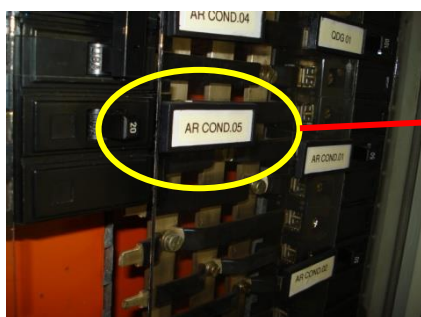
Figura 7 – Identificados de circuitos do quadro de distribuição.
