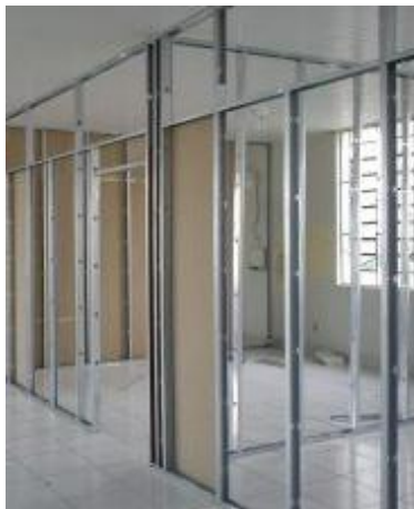
Figura 1 – Estrutura metálica do Drywall (guias e montantes).
