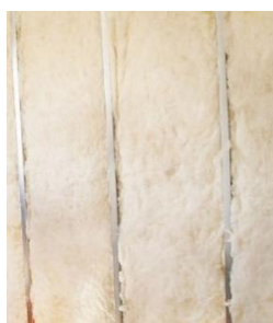
Figura 2 – Lã de rocha, aumento do isolamento térmico e acústico.
