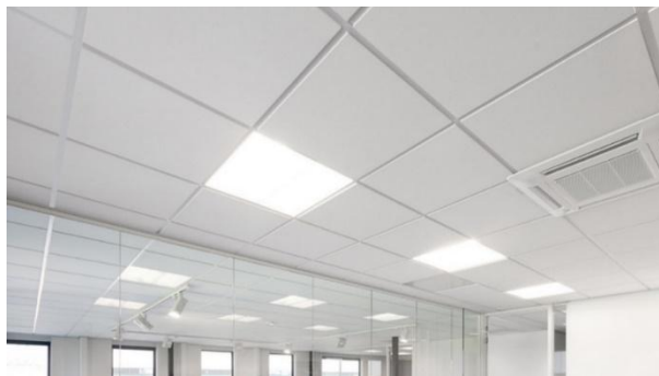
Figura 4 – Forro removível modular.
