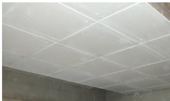
Figura 5 – Forro em placas de gesso.
