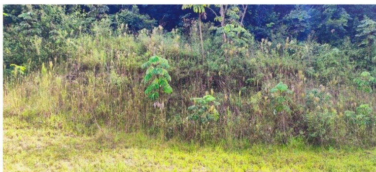
Figura 01 – Vista do local em que será executado a terraplanagem.
