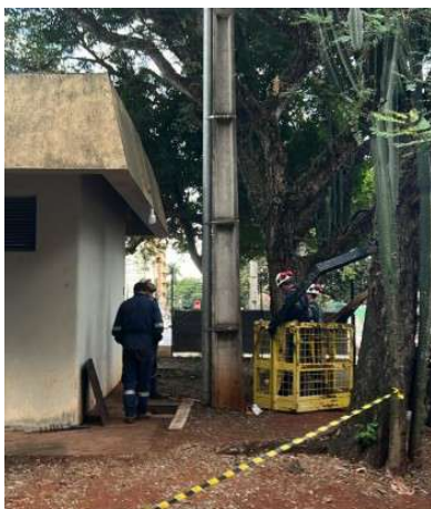
Conclusão dos trabalhos na subestação 13,8kV
