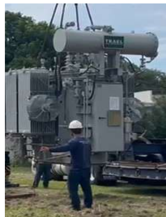
Içamento para colocação do transformador na base
