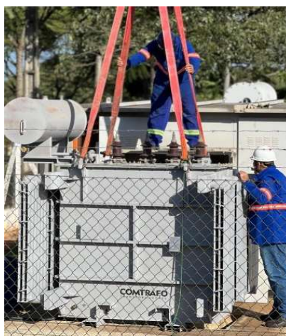
Equipe trabalhando na instalação do transformador de aterramento
