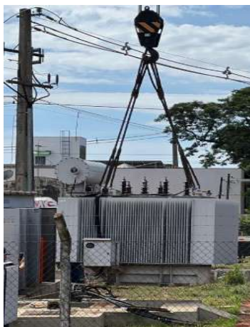
Retirada de um dos transformadores danificados
