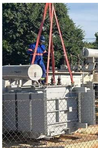
Equipe trabalhando na instalação do transformador de aterramento
