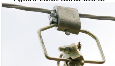
Figura 6: Estribo com conectores.
