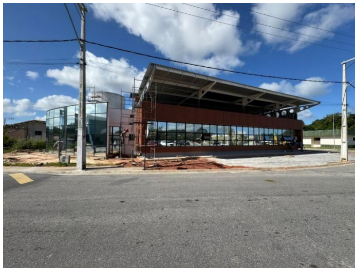
Figura 4 - Fotografia da construção do CEO de Saquarema.
