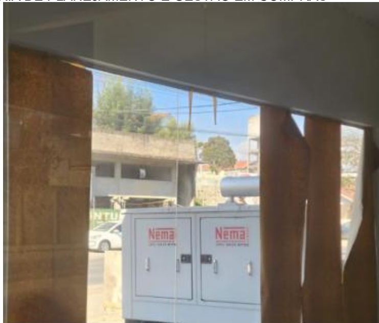
Fachada da sala da Rede de Fro com Papel Kraft, onde ficam armazenados as vacinas e imunobiológicos, como soros antivenenos para acidentes com cobras, aranhas, botulismo etc, e que não podem sofrer incidência solar.
