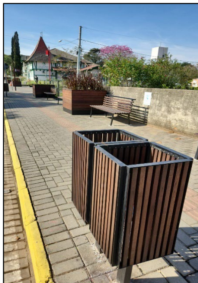
Lixeiras, Bancos e Floreiras já instalados na estrutura existente
