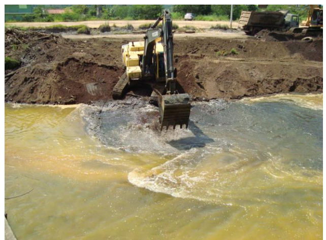
Figura 8: Escavadeira adentrando no leito.
