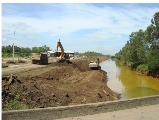
Figura 11: Escavação do fundo para prolongamento do acesso
