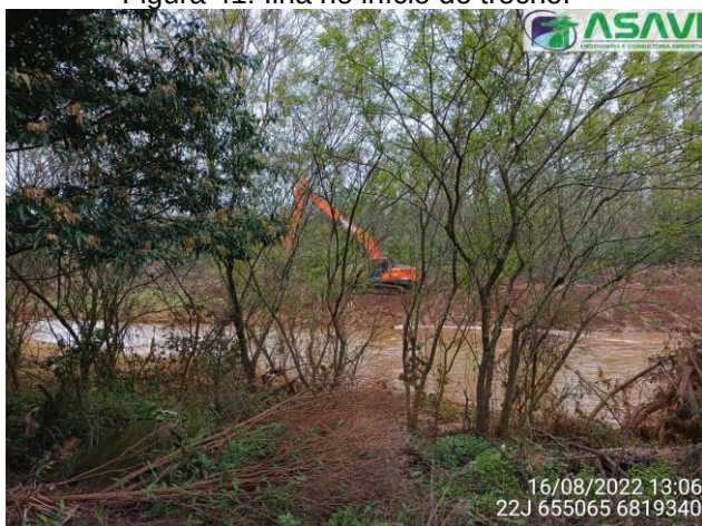
Figura 43: Limpeza na margem esquerda em Sangão em Criciúma sendo executada.
