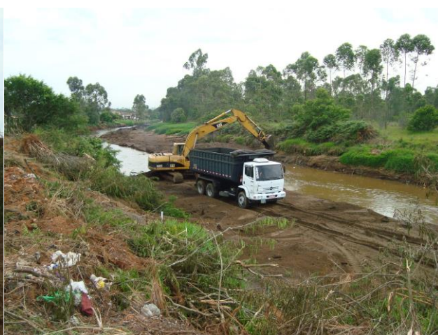
Figura 14: Retirada do acesso e afundamento da
