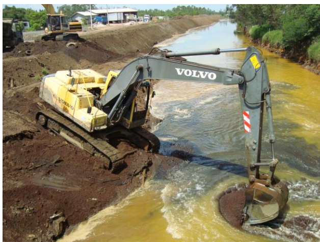
Figura 9: Escavação do fundo.
