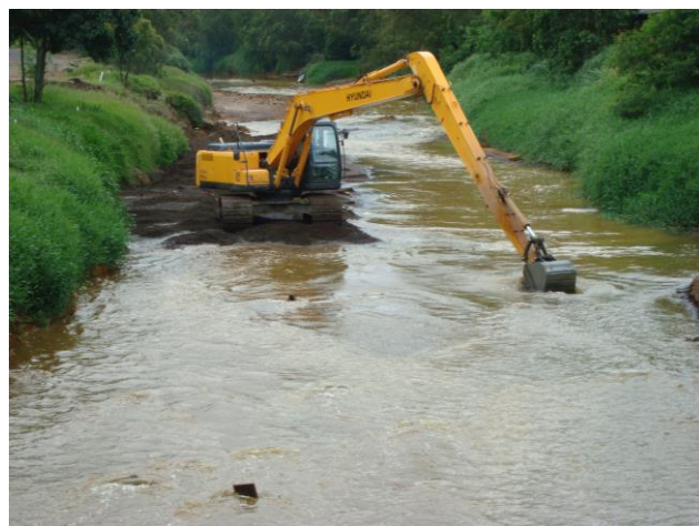
Figura 10: Construção do acesso com o material retirado do fundo.
