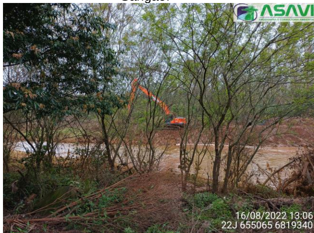
Figura 13: Limpeza na margem esquerda em Sangão em Criciúma sendo executada.
