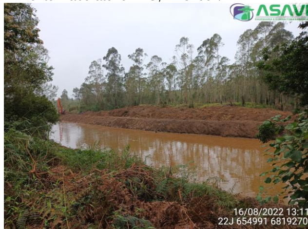
Figura 2014: Limpeza na margem esquerda em Criciúma sendo executada.
