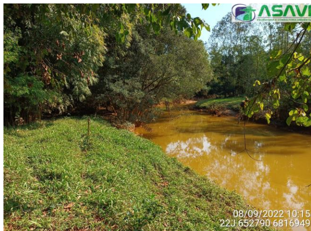
Figura 50: Visão geral Bairro São José entre as seções 16 e 17.
