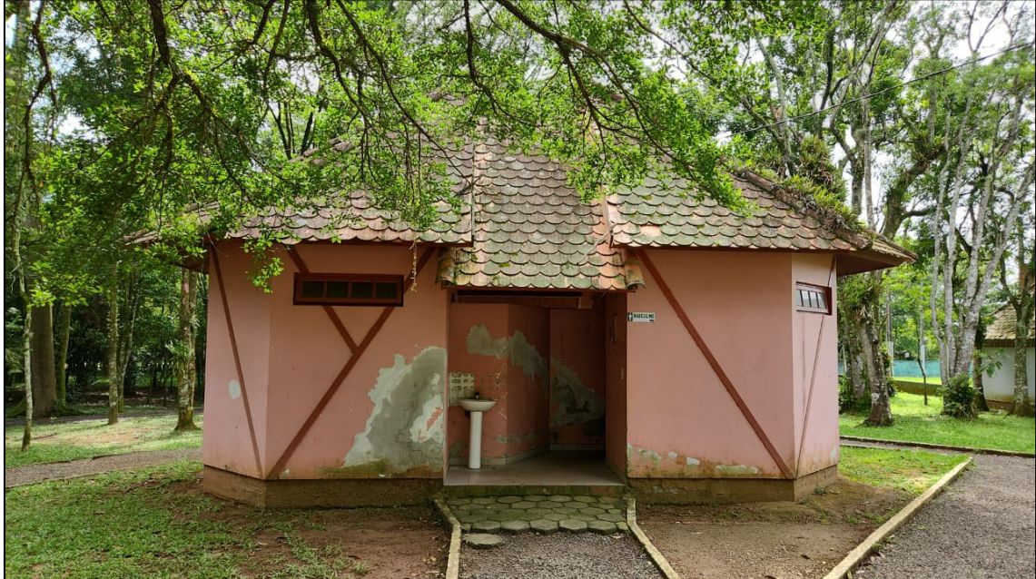
Banheiros – (Demolição) e construir novo em outra área do parque
