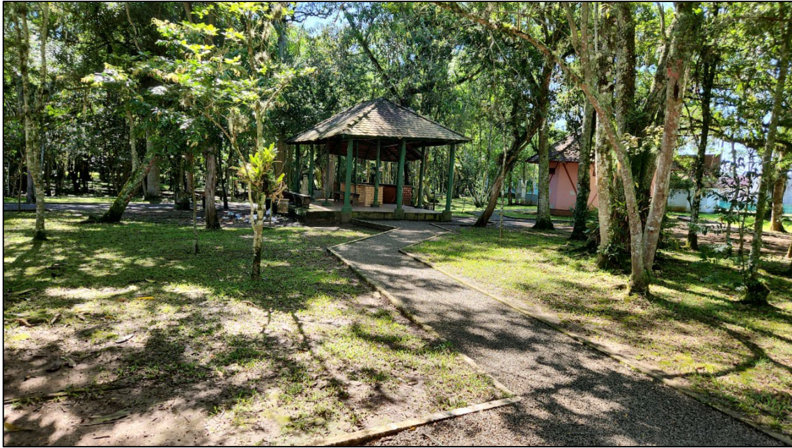
Quiosque – remover meio fio e demolir quiosque
