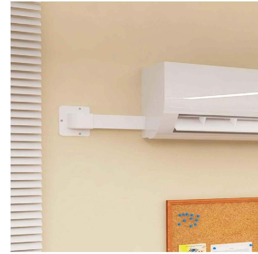
Detalhe de instalação das canaletas na evaporadora Sem escala
