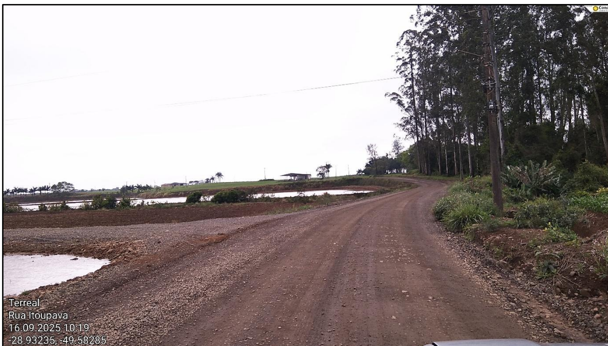
Figura 40 - Trecho da Rodovia TVO 359 a ser pavimentado
