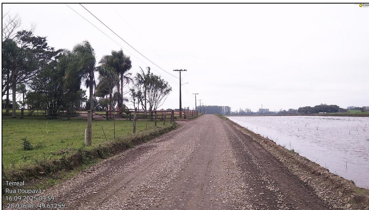
Figura 16 - Trecho da Rodovia TVO 362 a ser pavimentado
