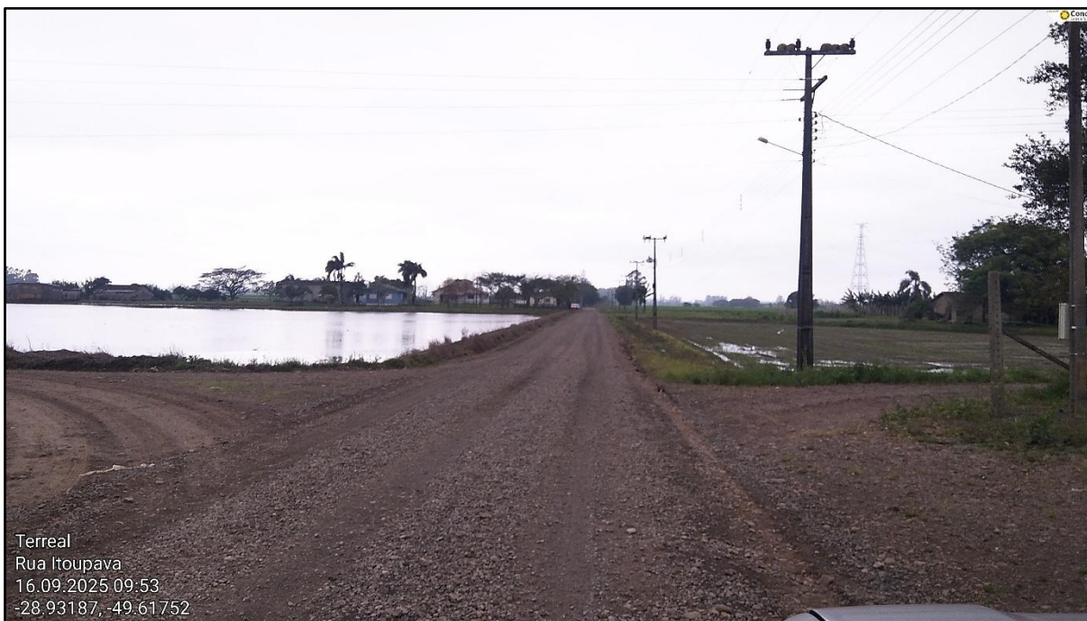
Figura 12 - Trecho da Rodovia TVO 362 a ser pavimentado
