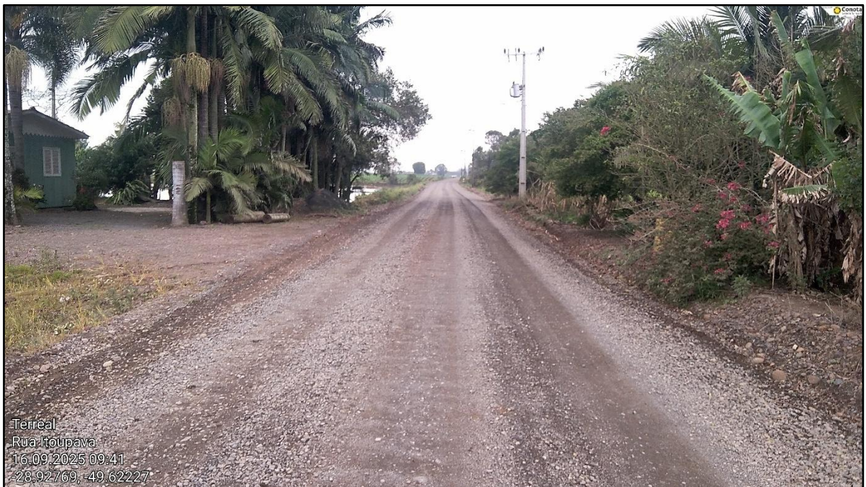
Figura 8 - Trecho da Rodovia TVO 362 a ser pavimentado
