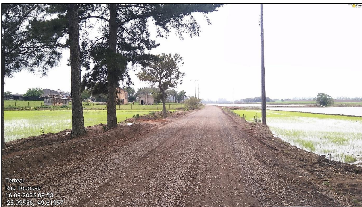
Figura 15 - Trecho da Rodovia TVO 362 a ser pavimentado
