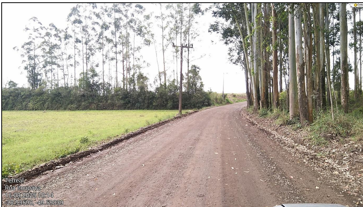
Figura 33 – Trecho da Rodovia TVO 359 a ser pavimentado
