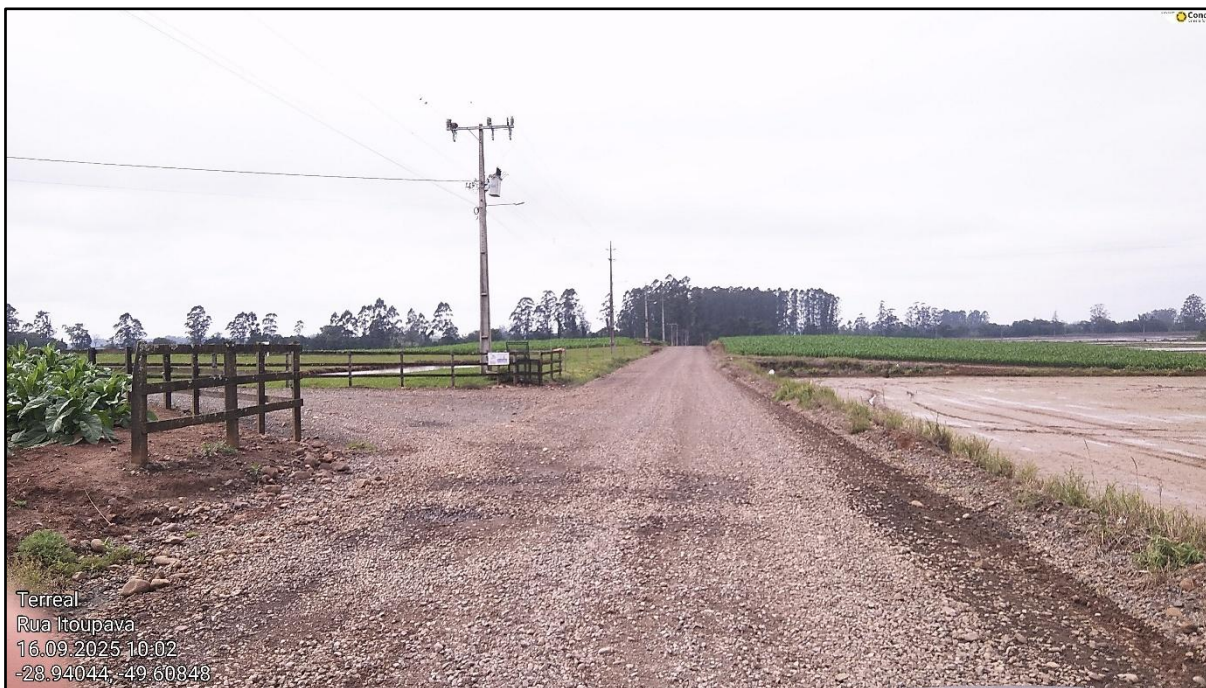
Figura 19 – Trecho da Rodovia TVO 362 a ser pavimentado
