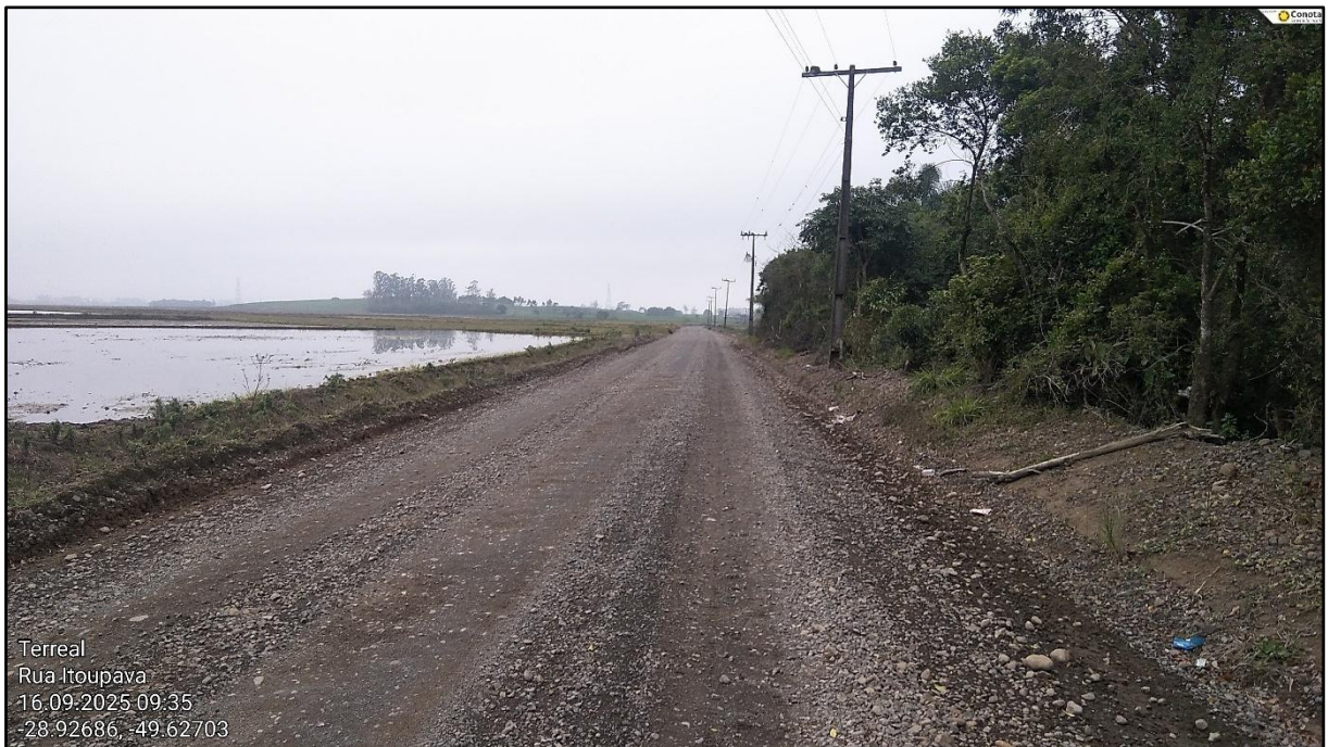
Figura 3 - Trecho da Rodovia TVO 362 a ser pavimentado
