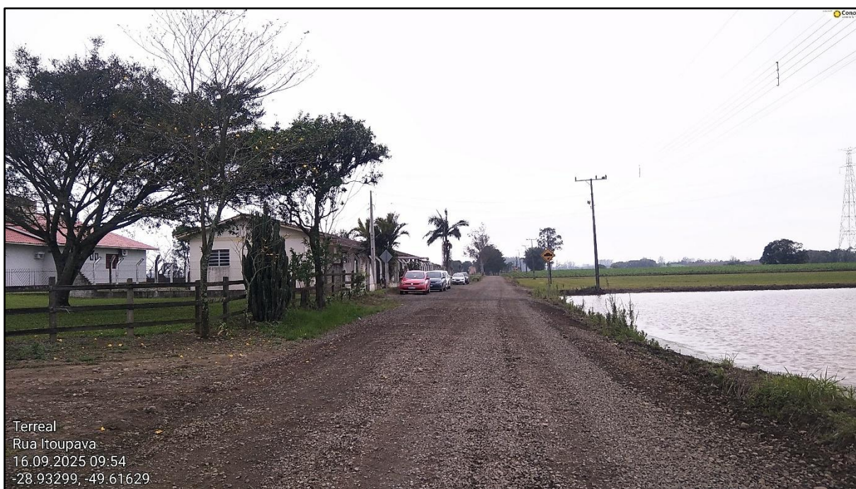
Figura 13 – Trecho da Rodovia TVO 362 a ser pavimentado
