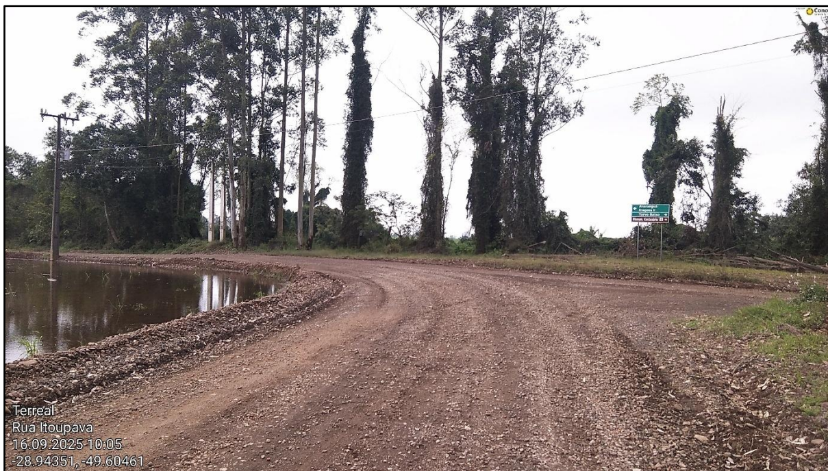
Figura 23 – Trecho da Rodovia TVO 362 a ser pavimentado
