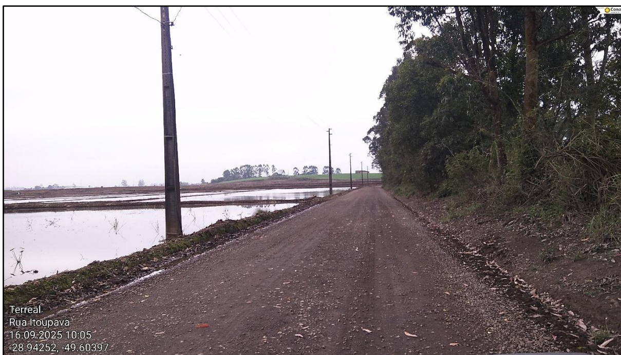
Figura 25 – Trecho da Rodovia TVO 359 a ser pavimentado
