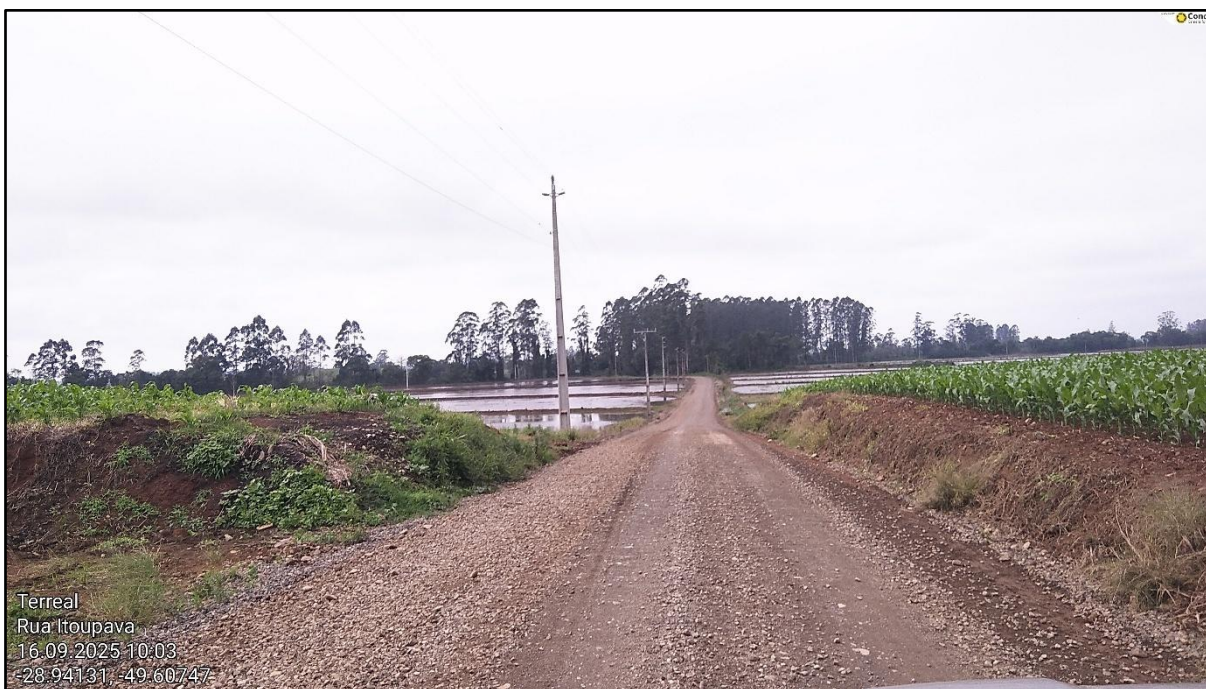
Figura 20 - Trecho da Rodovia TVO 362 a ser pavimentado
