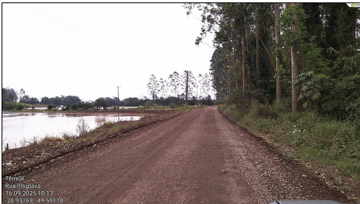
Figura 32 - Trecho da Rodovia TVO 359 a ser pavimentado
