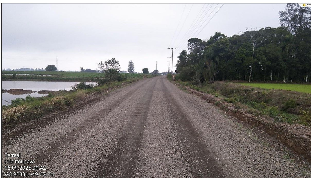
Figura 9 - Trecho da Rodovia TVO 362 a ser pavimentado
