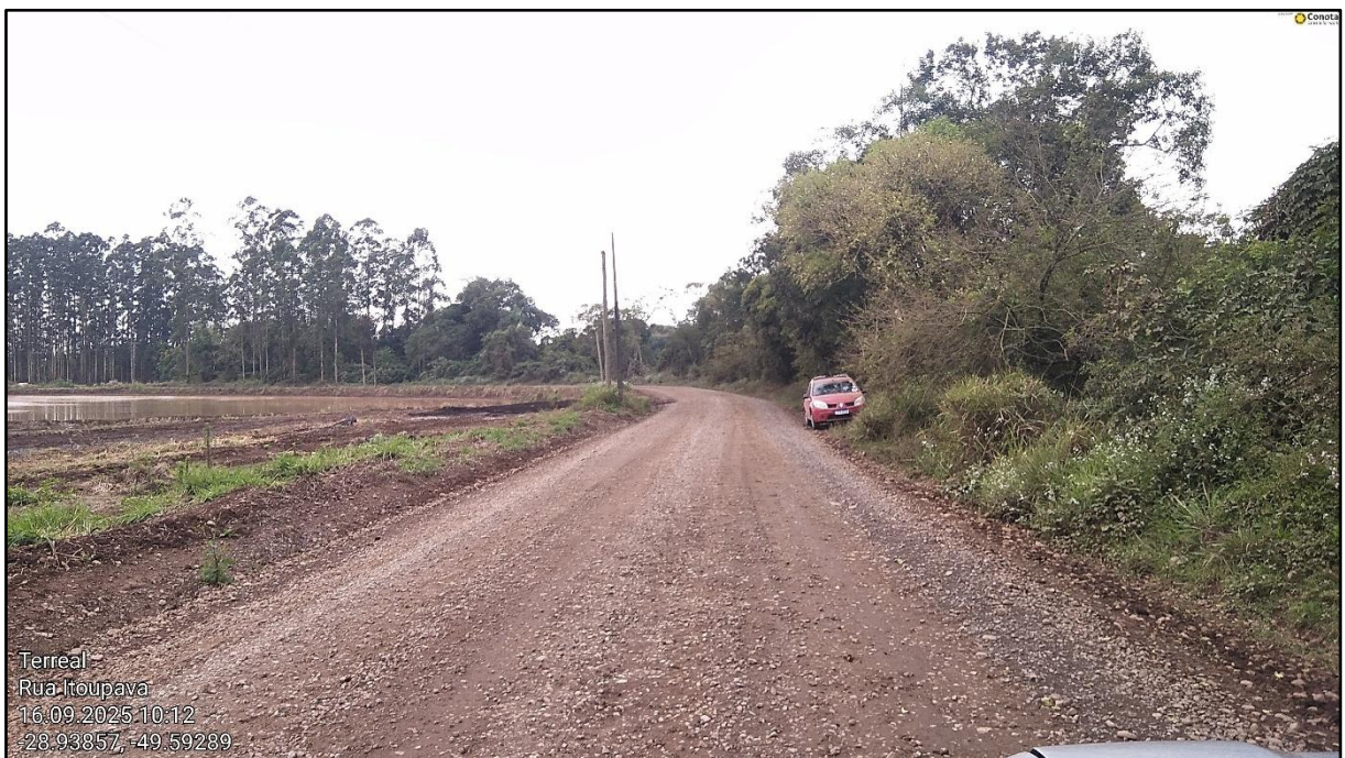
Figura 30 - Trecho da Rodovia TVO 359 a ser pavimentado
