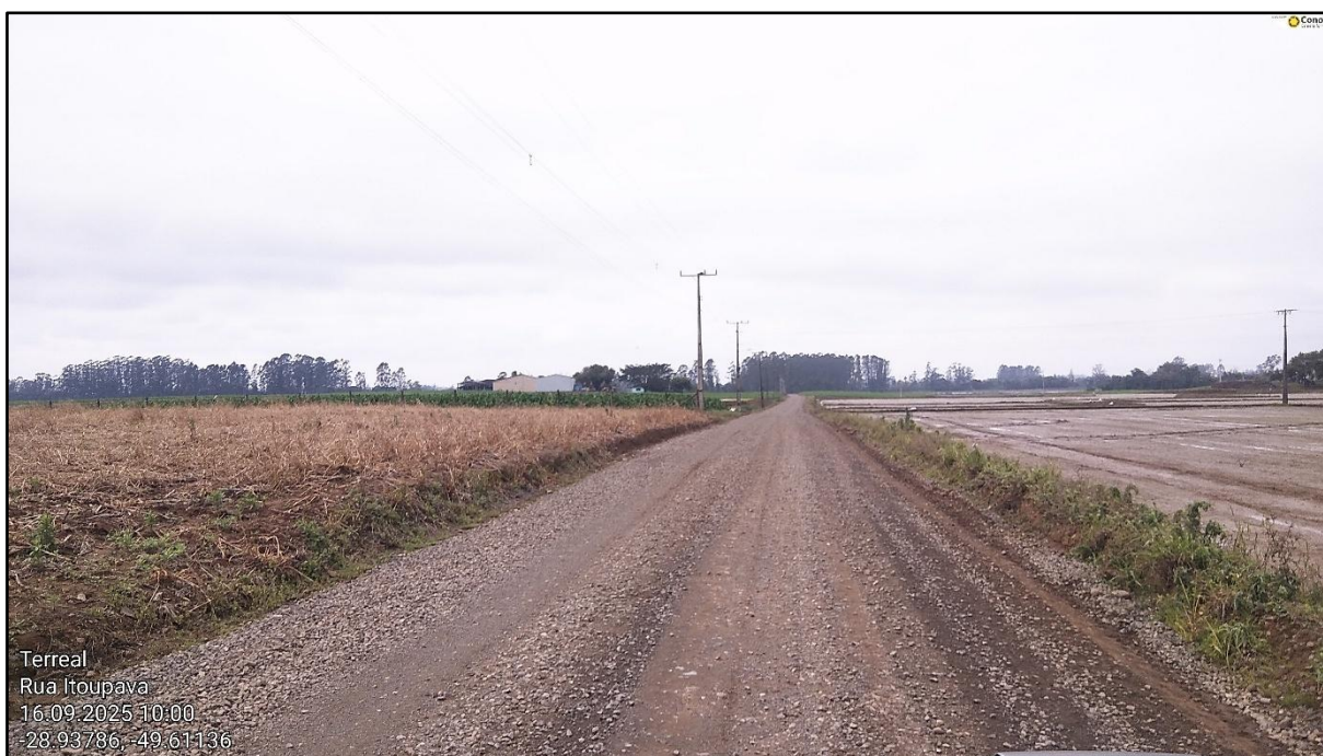
Figura 17 - Trecho da Rodovia TVO 362 a ser pavimentado
