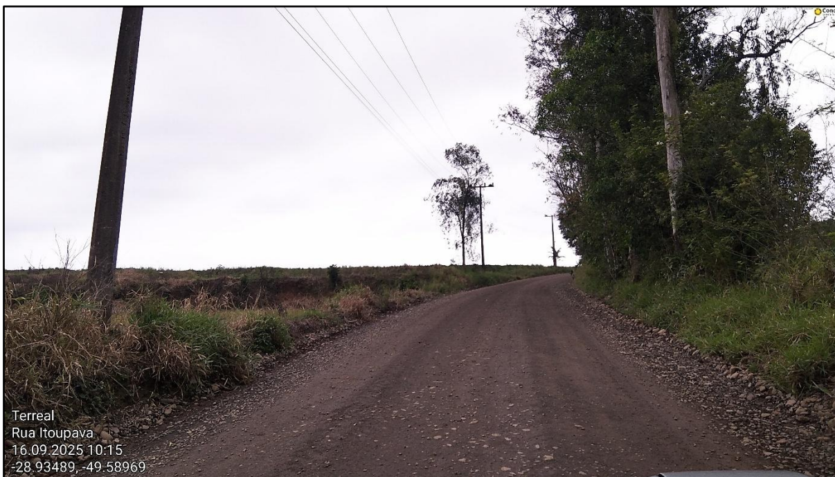
Figura 34 - Trecho da Rodovia TVO 359 a ser pavimentado
