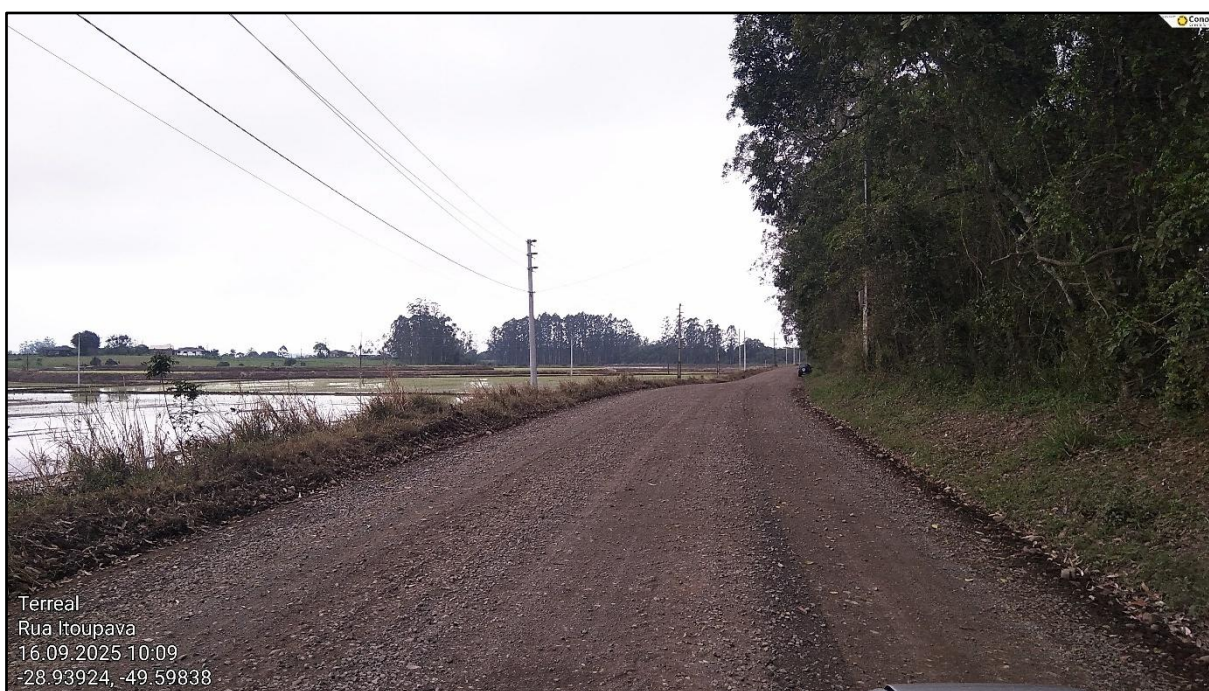
Figura 28 - Trecho da Rodovia TVO 359 a ser pavimentado
