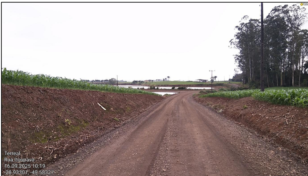
Figura 39 – Trecho da Rodovia TVO 359 a ser pavimentado
