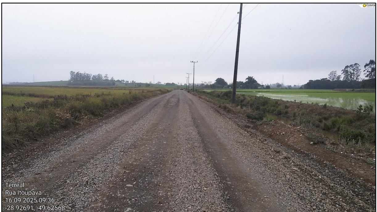
Figura 4 - Trecho da Rodovia TVO 362 a ser pavimentado
