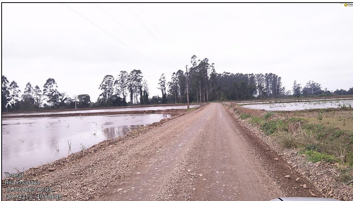
Figura 21 – Trecho da Rodovia TVO 362 a ser pavimentado
