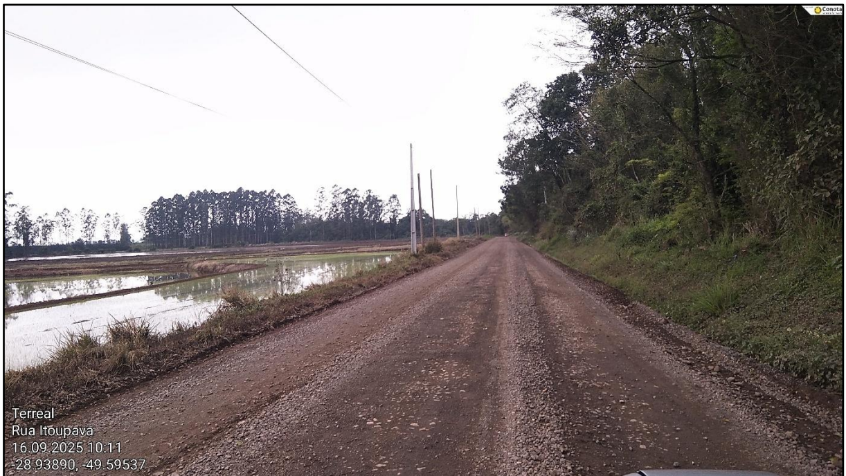
Figura 29 – Trecho da Rodovia TVO 359 a ser pavimentado
