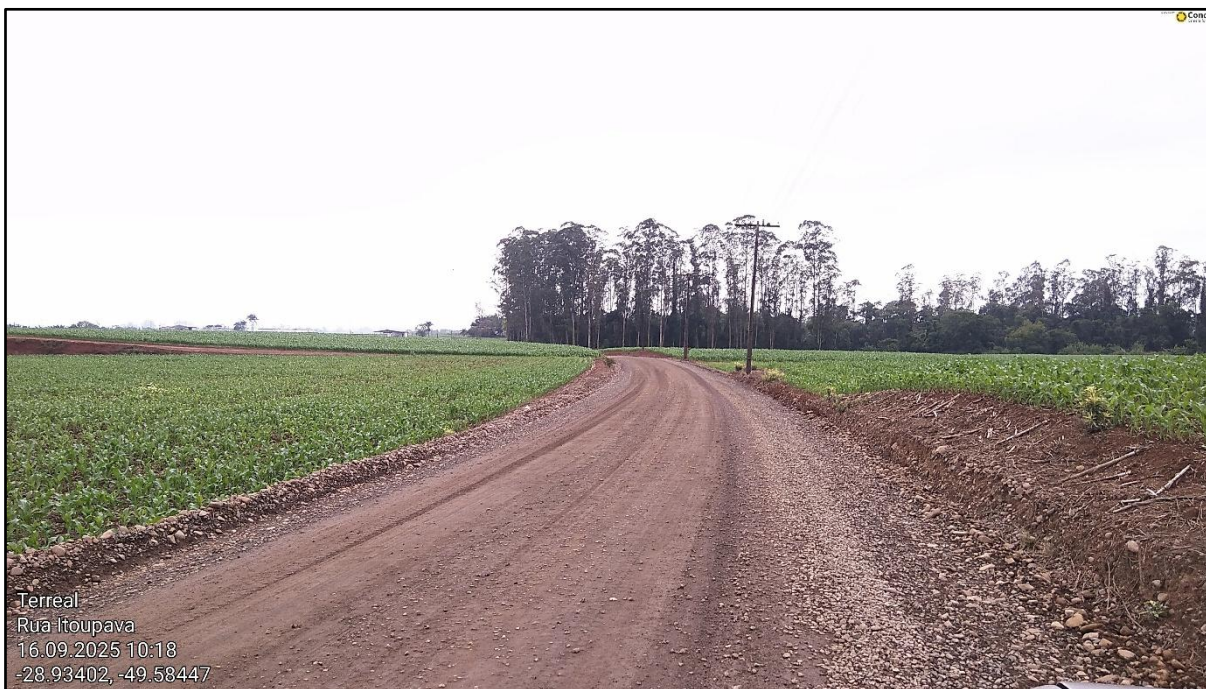
Figura 38 - Trecho da Rodovia TVO 359 a ser pavimentado
