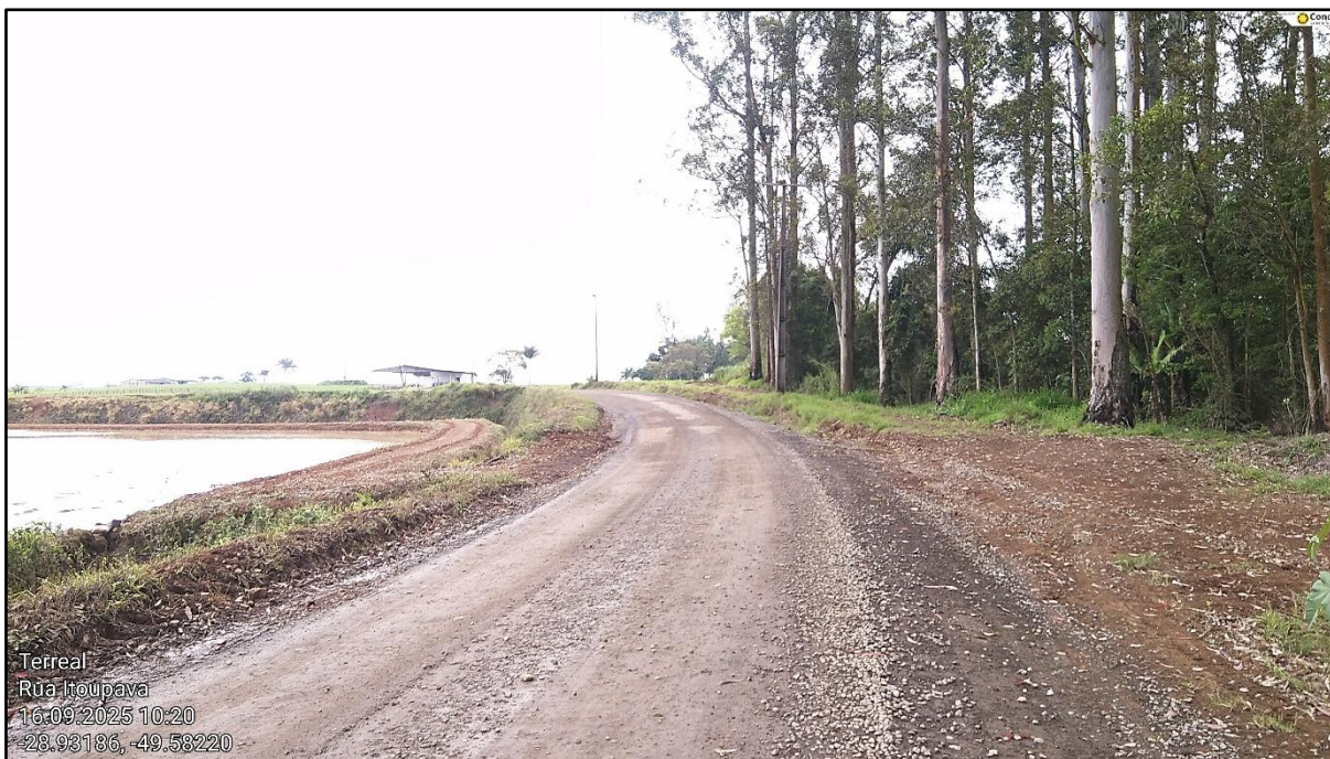
Figura 41 - Trecho da Rodovia TVO 359 a ser pavimentado
