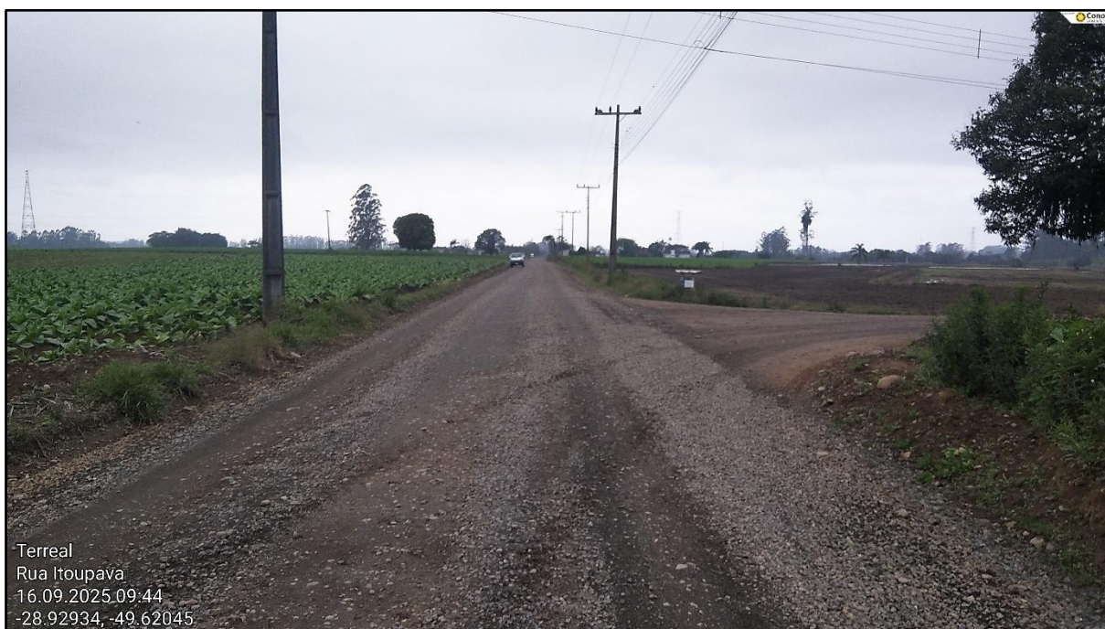
Figura 10 - Trecho da Rodovia TVO 362 a ser pavimentado
