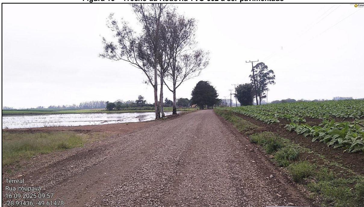
Figura 14 - Trecho da Rodovia TVO 362 a ser pavimentado
