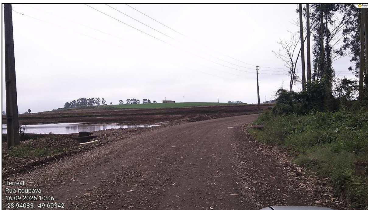
Figura 26 - Trecho da Rodovia TVO 359 a ser pavimentado
