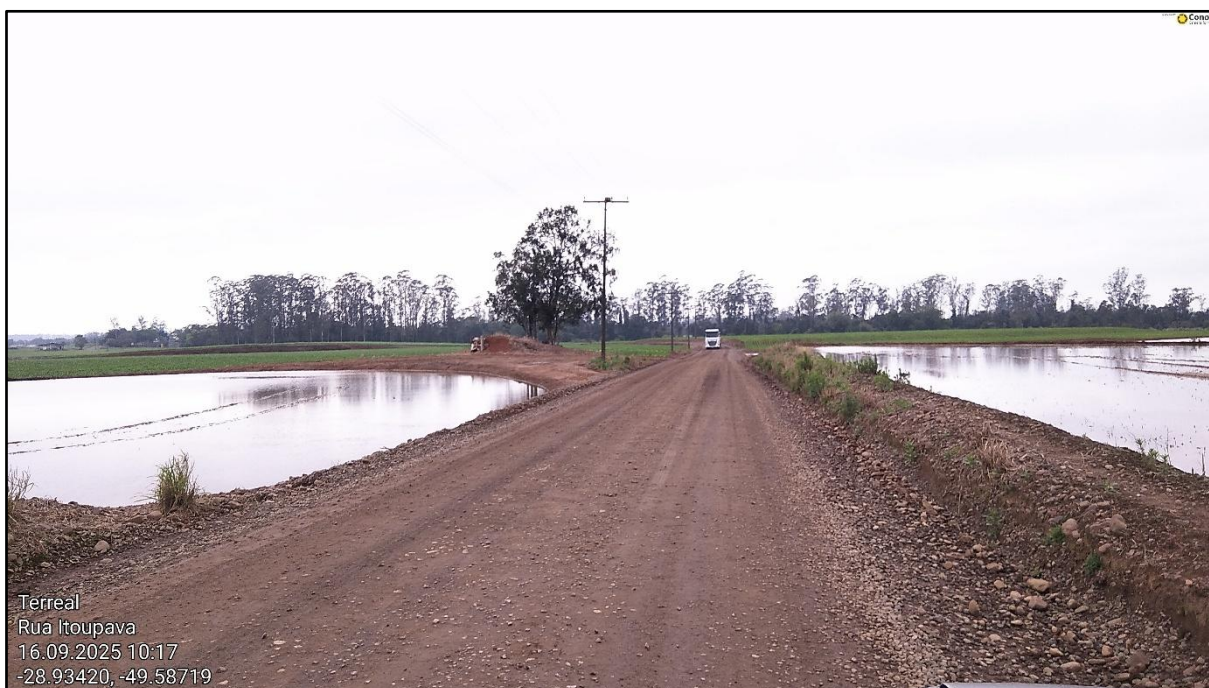
Figura 36 - Trecho da Rodovia TVO 359 a ser pavimentado
