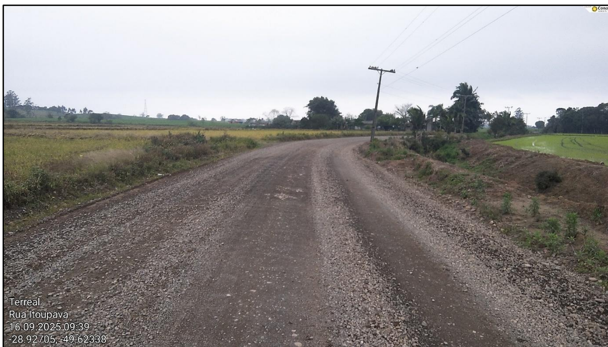
Figura 6 - Trecho da Rodovia TVO 362 a ser pavimentado
