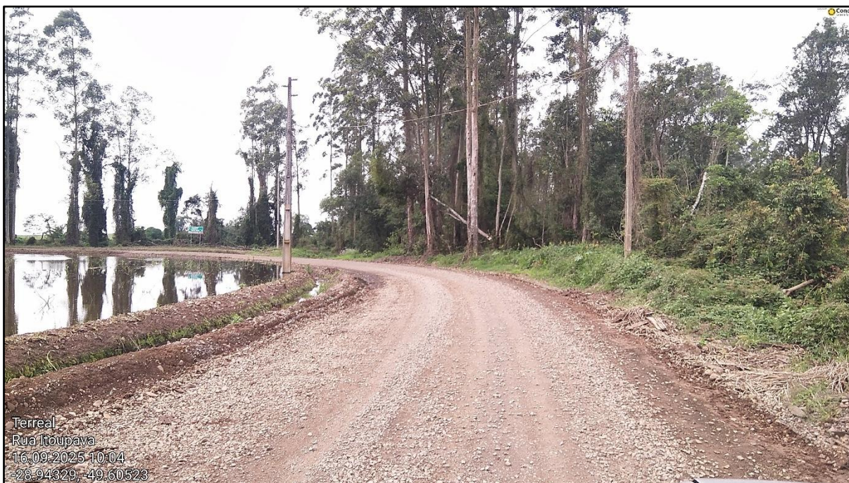
Figura 22 - Trecho da Rodovia TVO 362 a ser pavimentado
