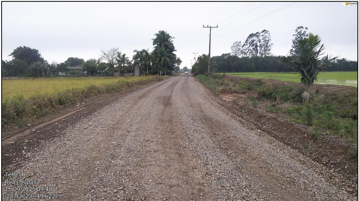
Figura 7 - Trecho da Rodovia TVO 362 a ser pavimentado
