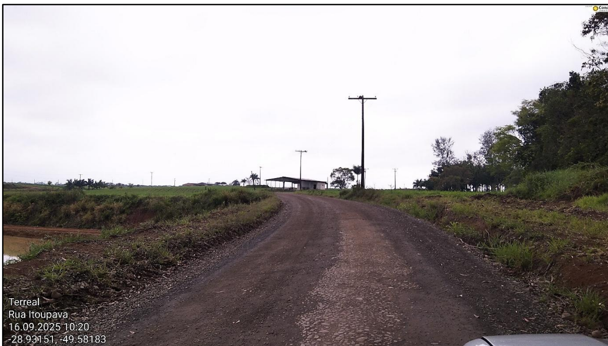
Figura 42 – Trecho da Rodovia TVO 359 a ser pavimentado
