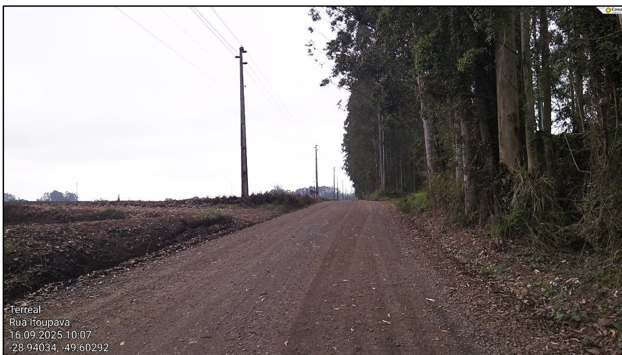
Figura 27 – Trecho da Rodovia TVO 359 a ser pavimentado
