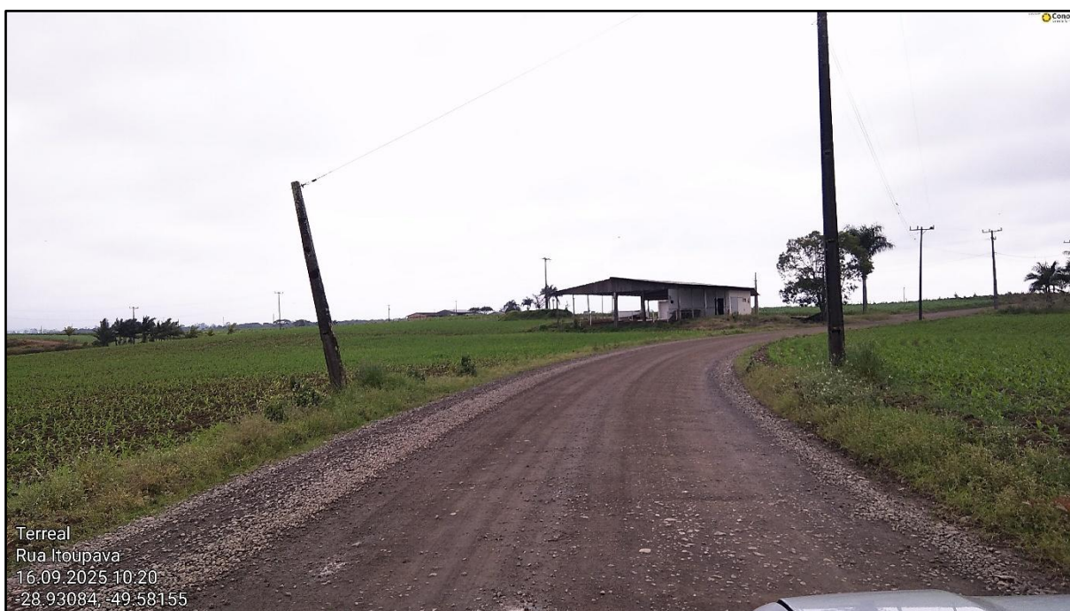
Figura 43 – Final do trecho da Rodovia TVO 359 a ser pavimentado.
