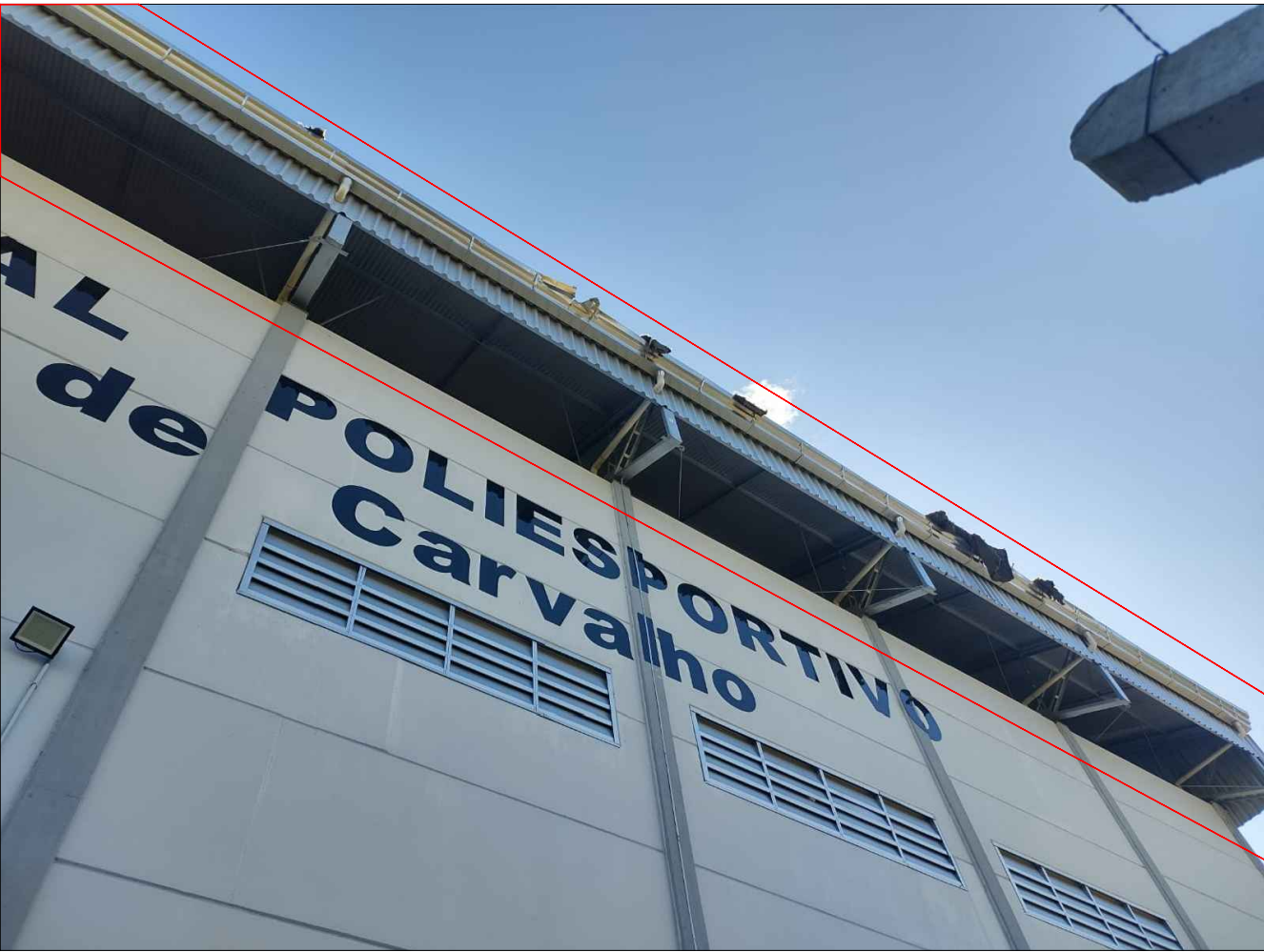
IMAGEM DA FACHADA LESTE DO GINÁSIO INDICAÇÃO DO VÃO QUE DEVERÁ SER FECHADO
