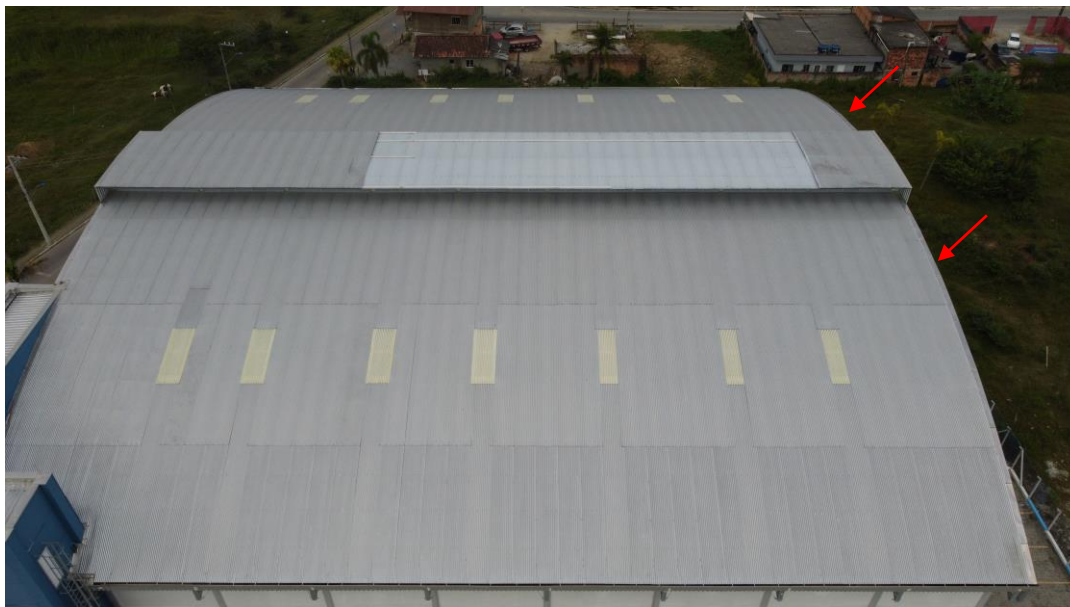
Figura 04 - Imagem aérea da cobertura do ginásio. Identificação do telhado que deverá ser costurado e reforçado com fixação em toda sua extensão. Arquivo pessoal.
