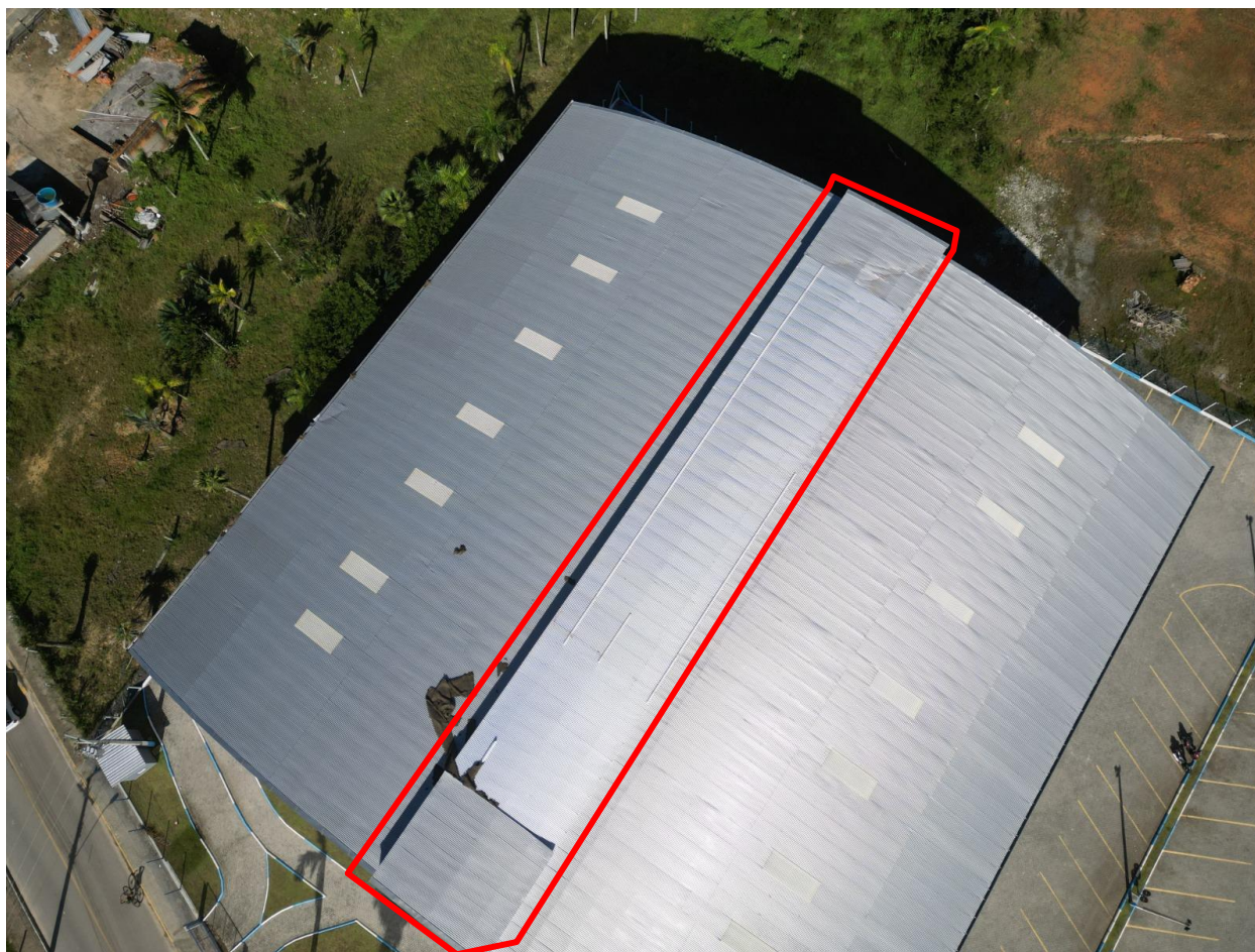
Figura 02 - Identificação do lanternim na cobertura da edificação. Área onde deverá ser realizada a remoção das telhas e perfil cartola atuais e execução de novo telhamento. Arquivo pessoal.
