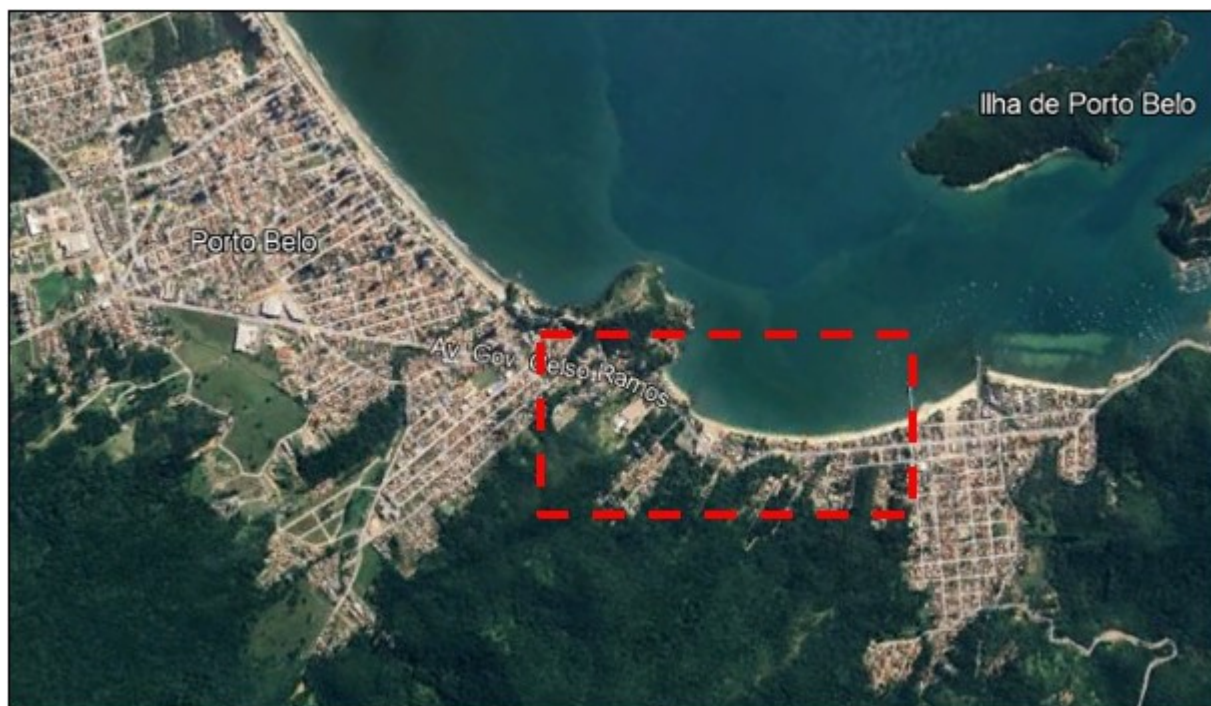
Figura 5. Trecho crítico da Avenida Governador Celso Ramos entre os bairros Vila Nova e Centro
