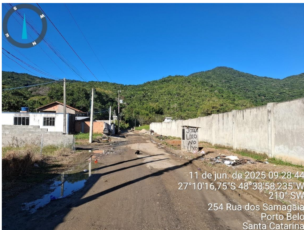
Figura 7 – Situação atual da Rua dos Samagaia - trecho 2
