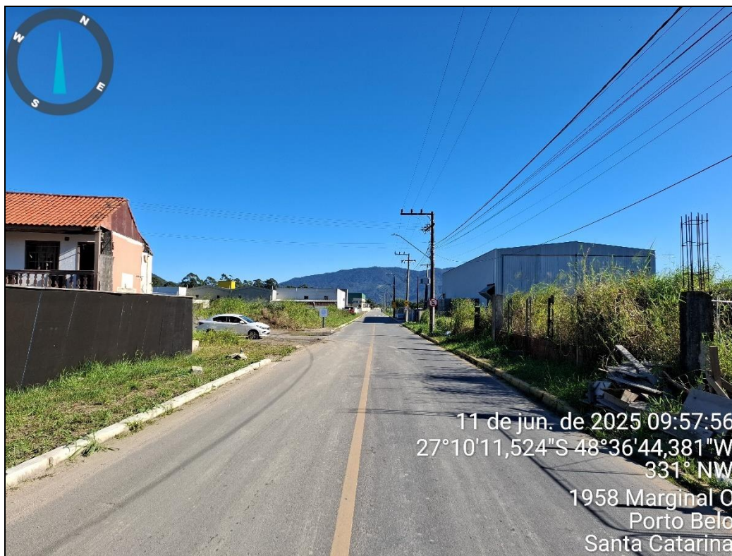
Figura 4 – Situação atual da Rua Aliatar Silva, pavimentada, sem passeios e ciclovia
