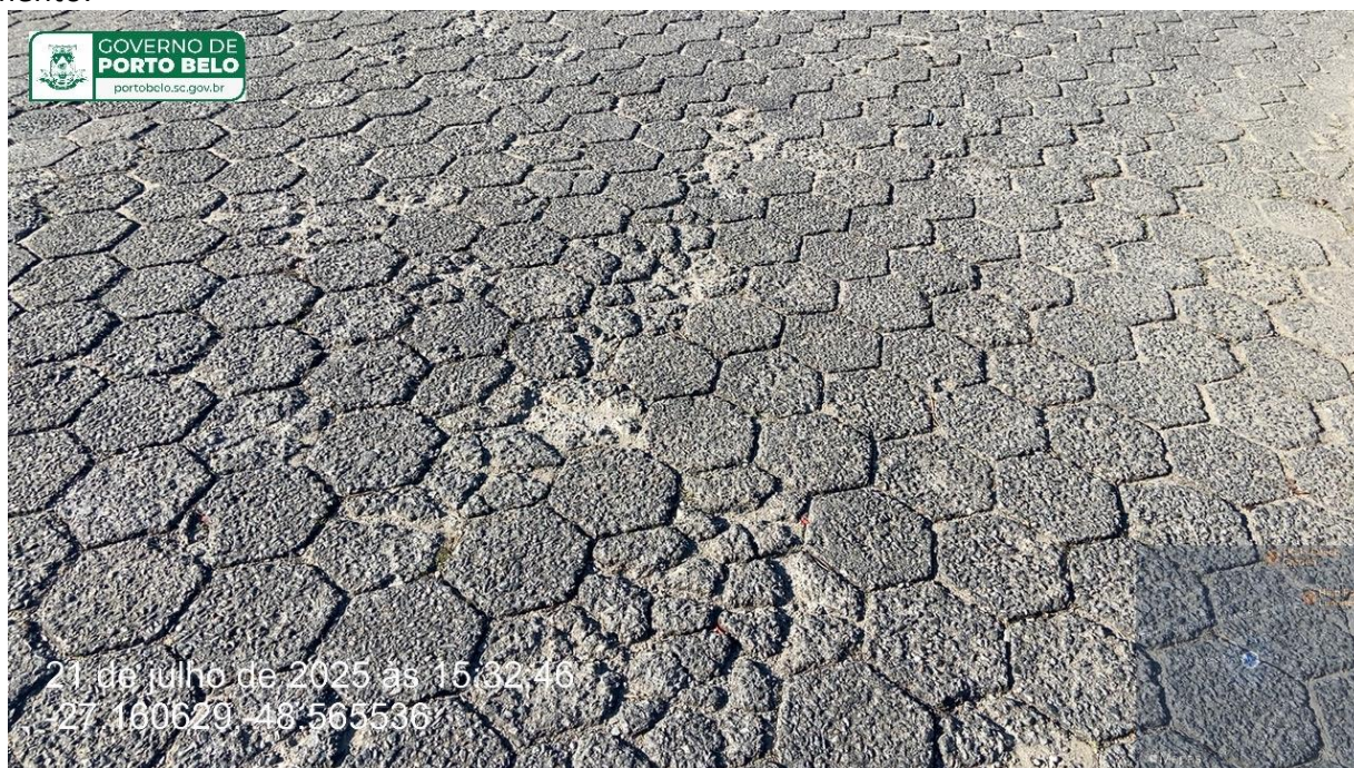
Figura 4 – Condições atuais de trecho da Rua Liberato Placido dos Santos, com deterioração do pavimento.
