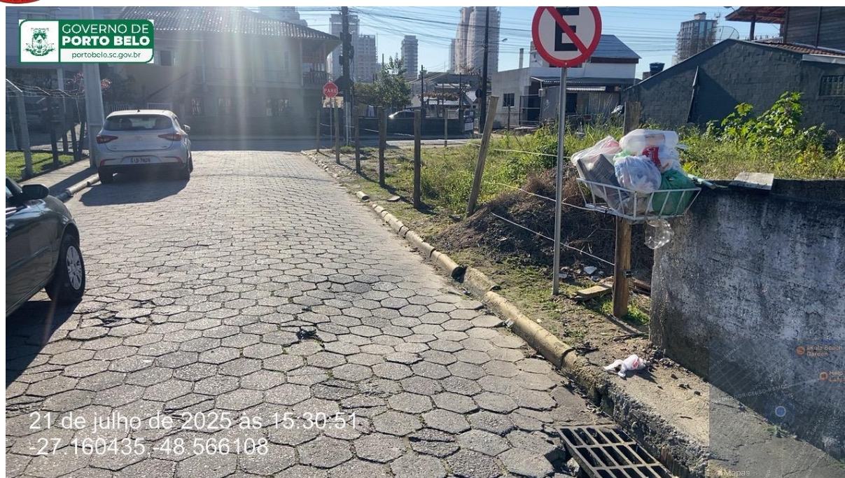
Figura 4 – Condições atuais de trecho da Rua Liberato Placido dos Santos, com deterioração do pavimento.
