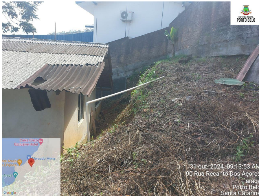
Figura 2 – Vista lateral do talude.
