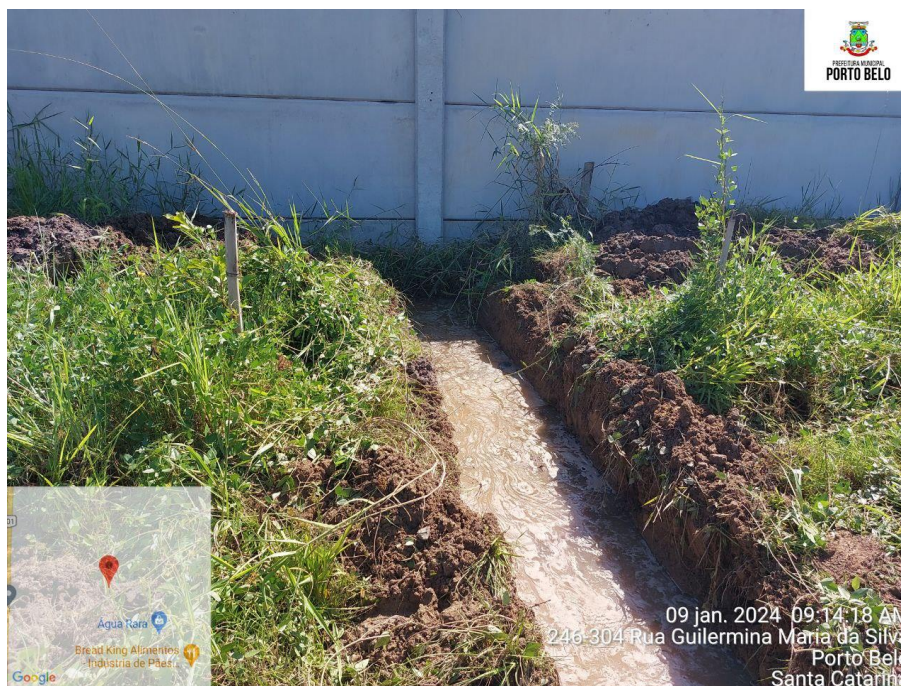
Abertura de valas de drenagem para escoar água pluvial acumulada.
