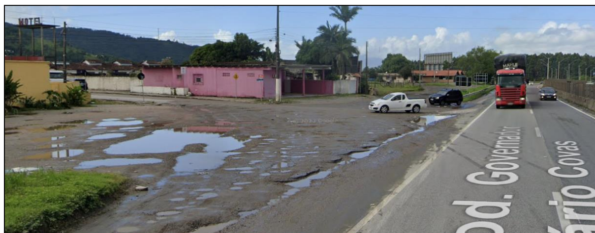
Figura 9 - Acesso Leste - Rua Pedro Romão
