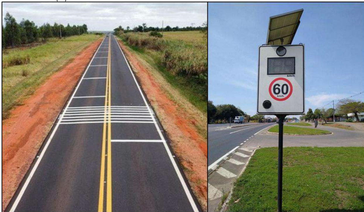
Figura 7. Redutores de velocidade indicados (A) Ondulação transversais (B) Faixa sonificadoras (C) Lombada eletrônica.
