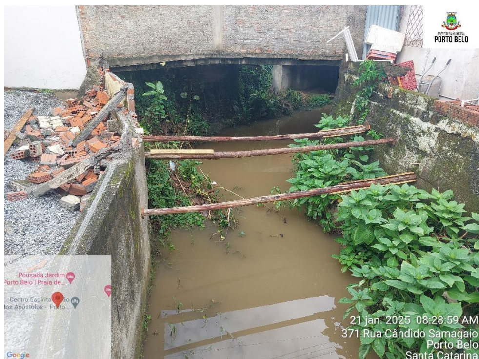
Figura 2 – Escoramento das margens, após primeiro deslizamento.
