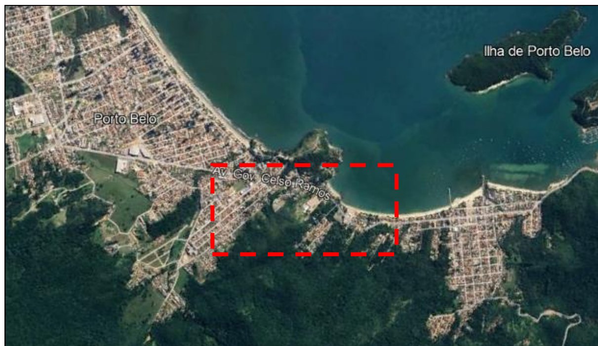
Figura 5. Trecho crítico da Avenida Governador Celso Ramos entre os bairros Vila Nova e Centro Fonte: Google Earth, acesso em 19/03/2024.
