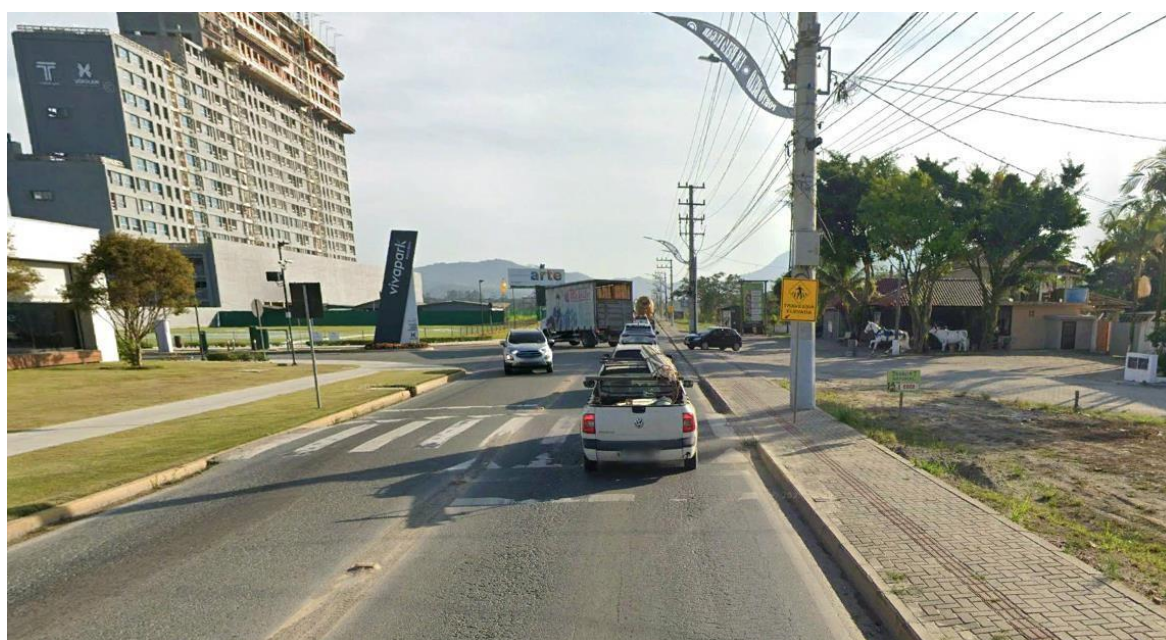
Figura 5 – Ponto crítico de acidentes na Avenida Governador Celso Ramos (trecho próximo ao acesso à Avenida Silvio Camargo)
