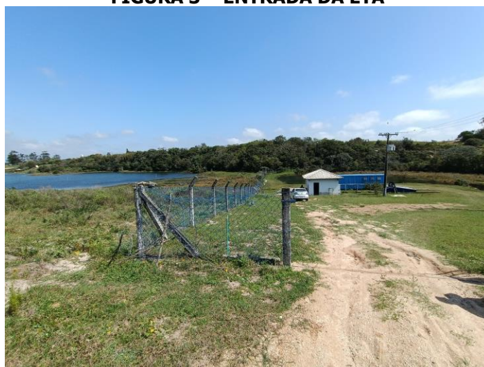
FIGURA 3 – ENTRADA DA ETA
