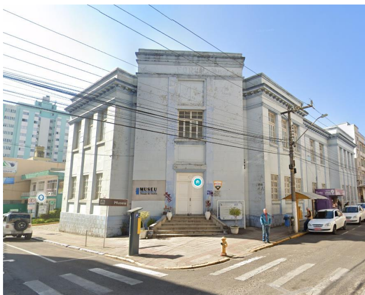
Figura 02. Fachada frontal da área de intervenção
