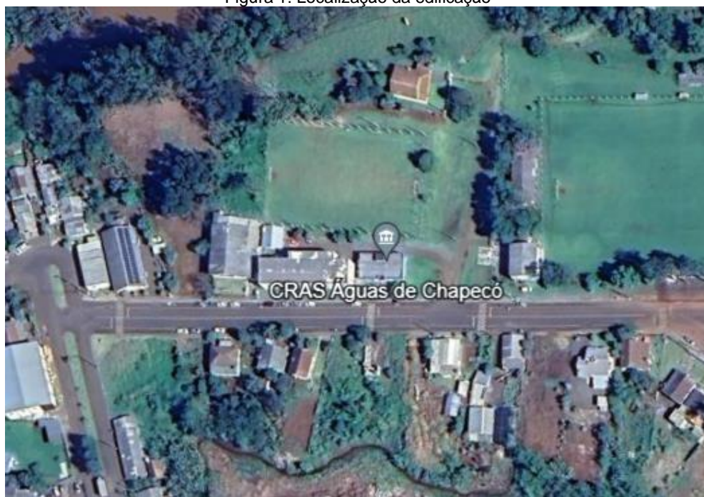
Figura 1: Localização da edificação
