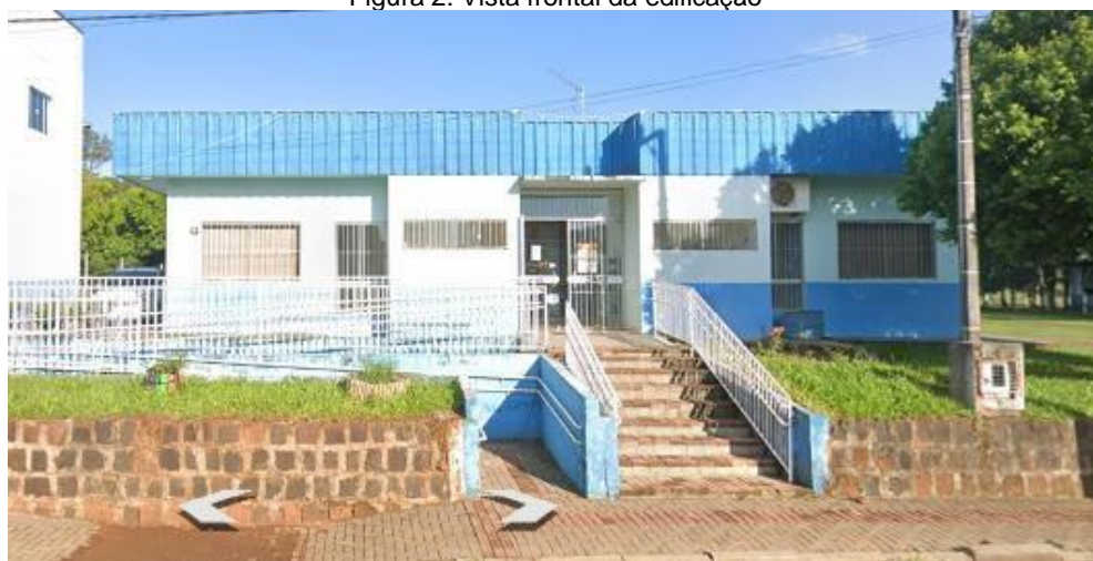
Figura 2: Vista frontal da edificação
