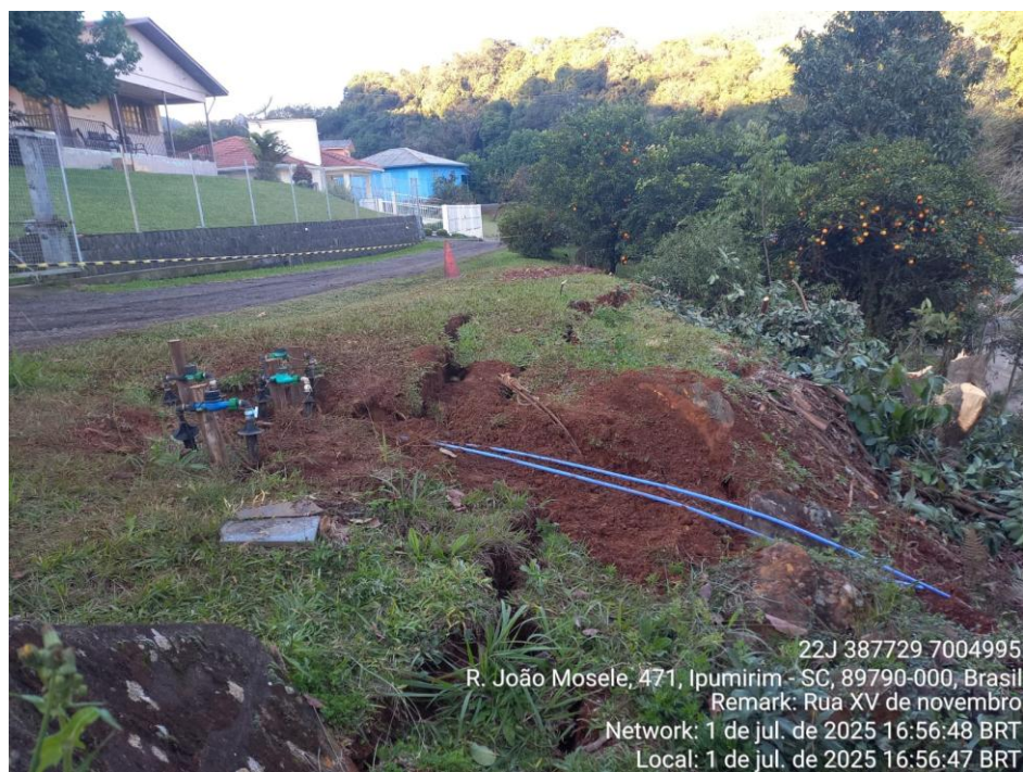
Legenda – situação das rachaduras 01/07 terça.
