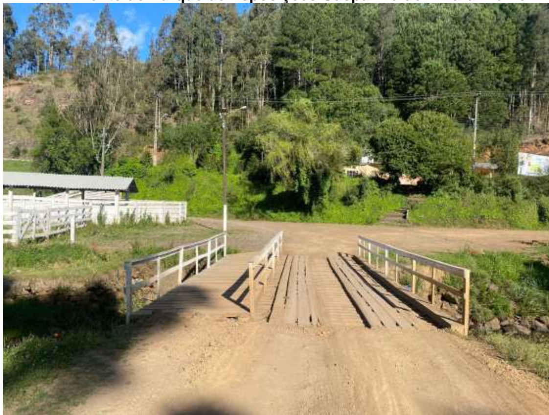
Figura 7: Situação atual da ponte;
