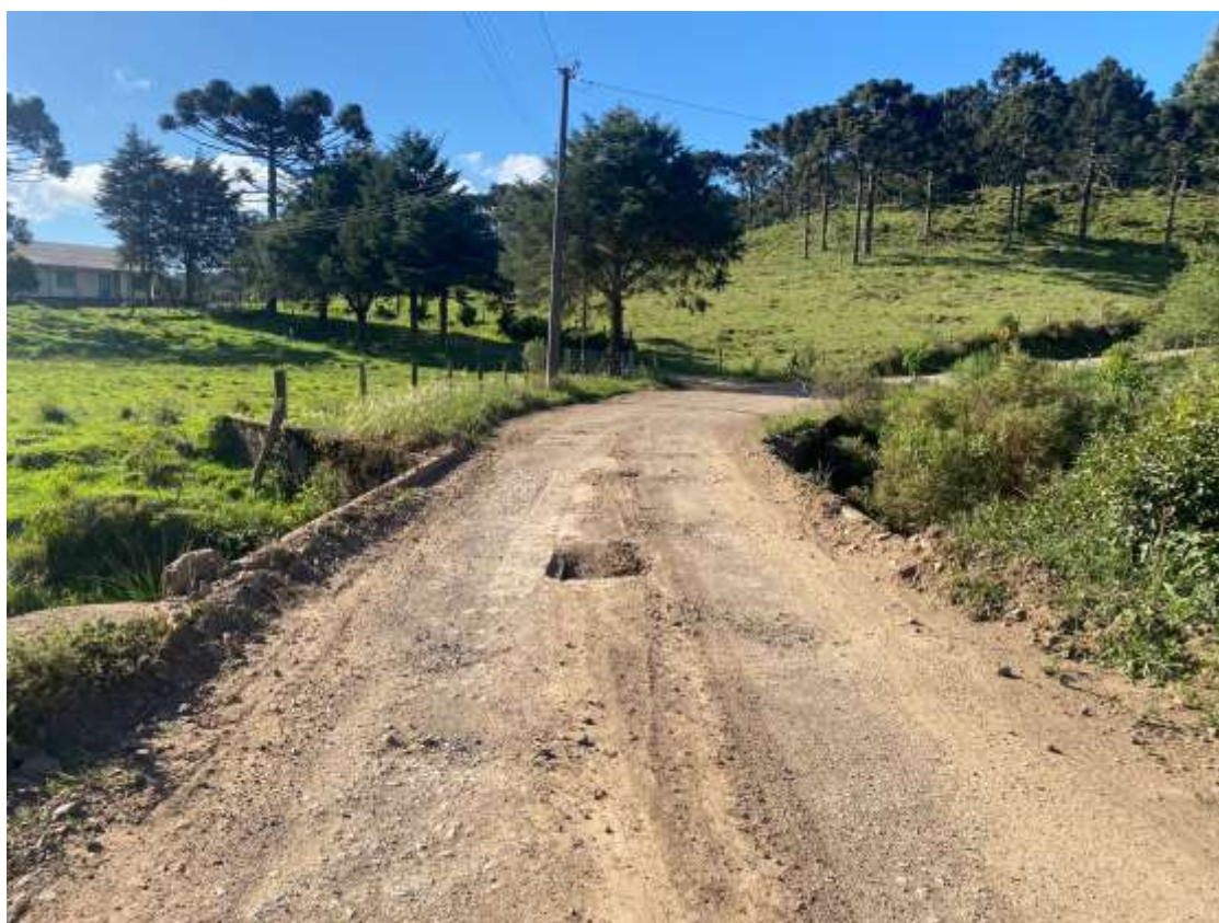
Figura 3: Situação atual da ponte;
