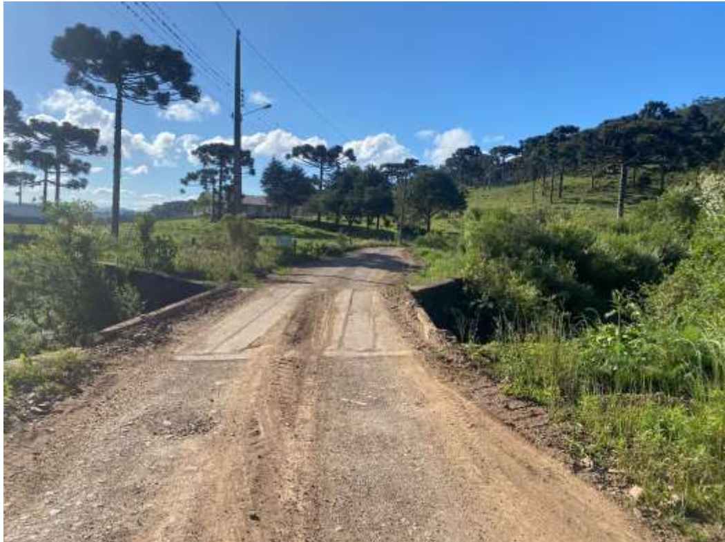
Figura 1: Situação atual da ponte;
