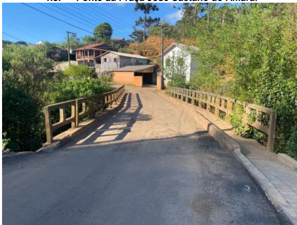
Figura 5: Situação atual da ponte;
