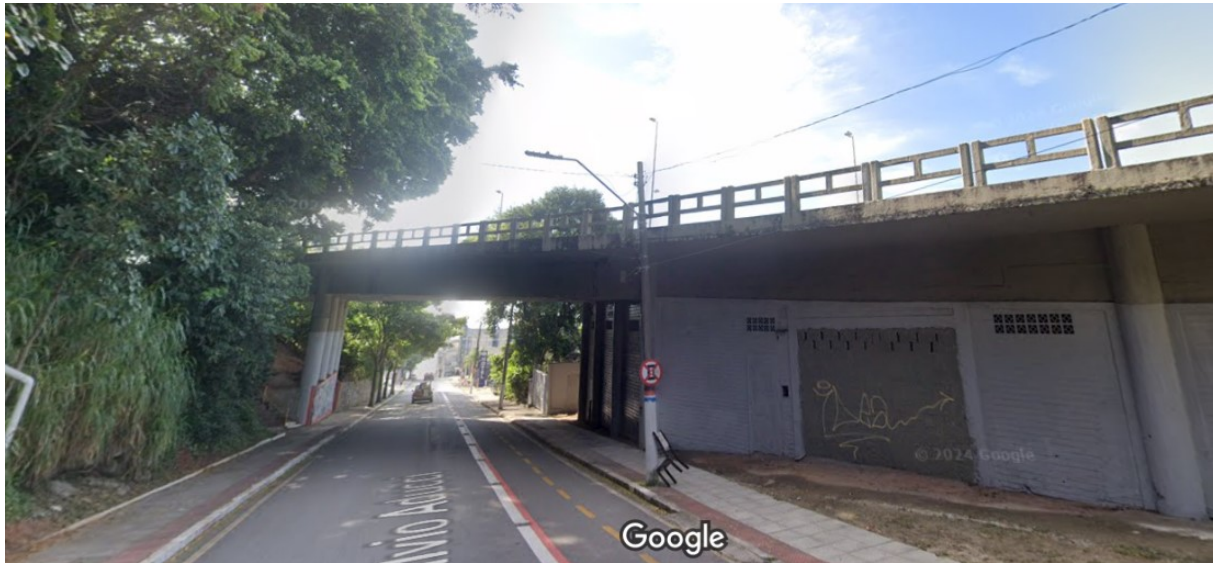
Vista inferior – Rua Fúlvio Aducci.
