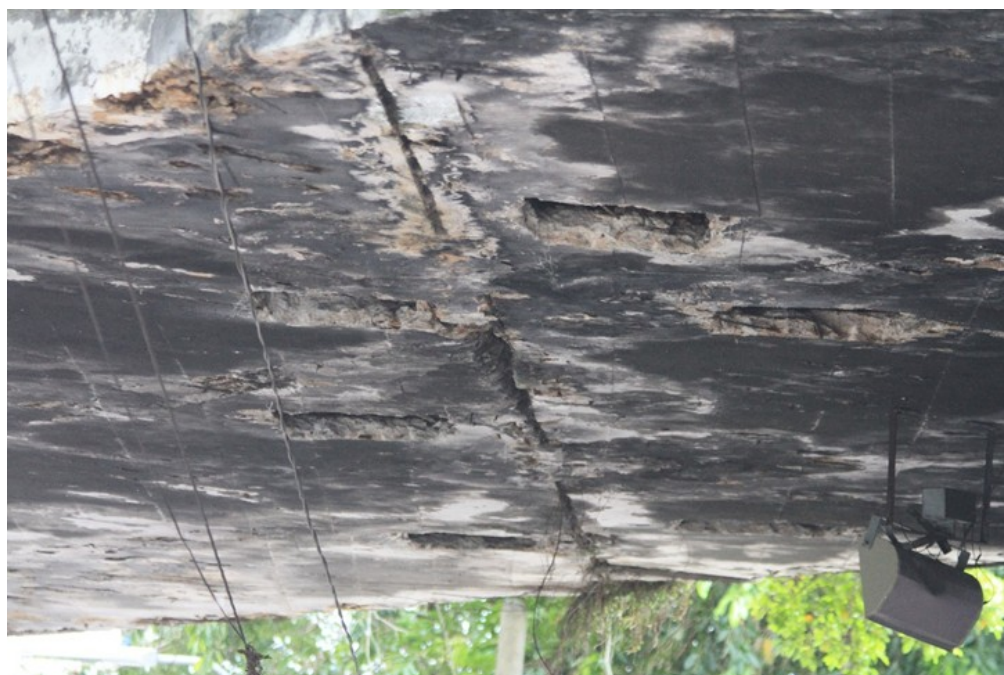
Figura 8: Vista inferior na região de junta
