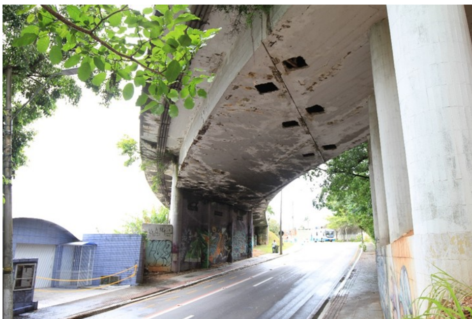
Figura 2: Vista inferior do vão principal
