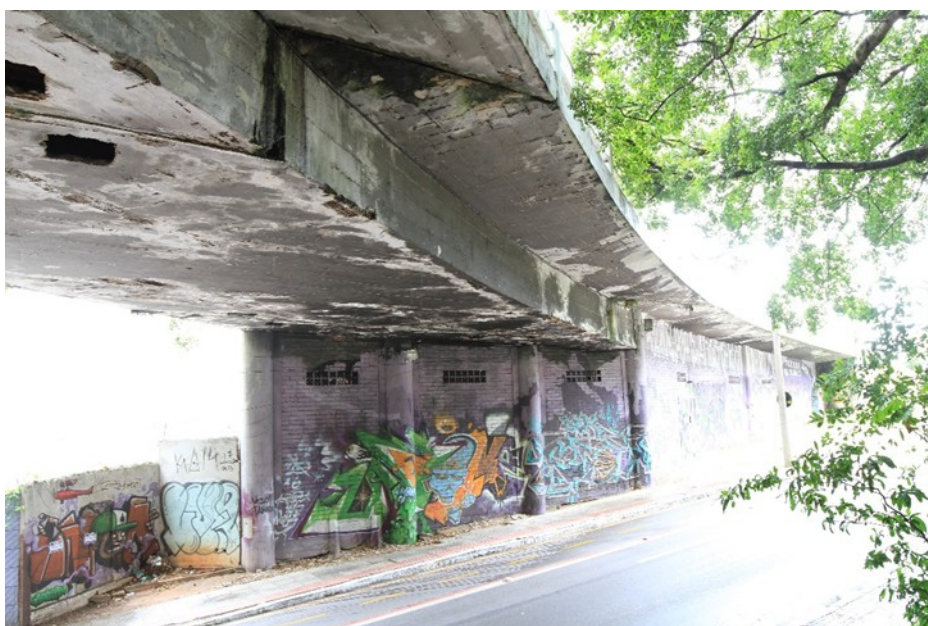
Figura 3: Vista inferior do vão principal
