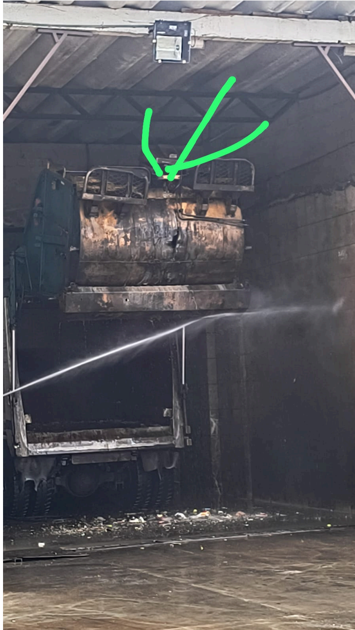
Figura 02. Foto da situação de corrosão da concha do caminhão compactador.
