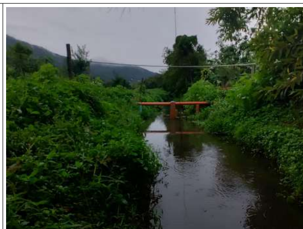
Figura 5.2 - Vista da vala e da adutora de esgoto nas proximidades da Servidão Ondas do Mar
