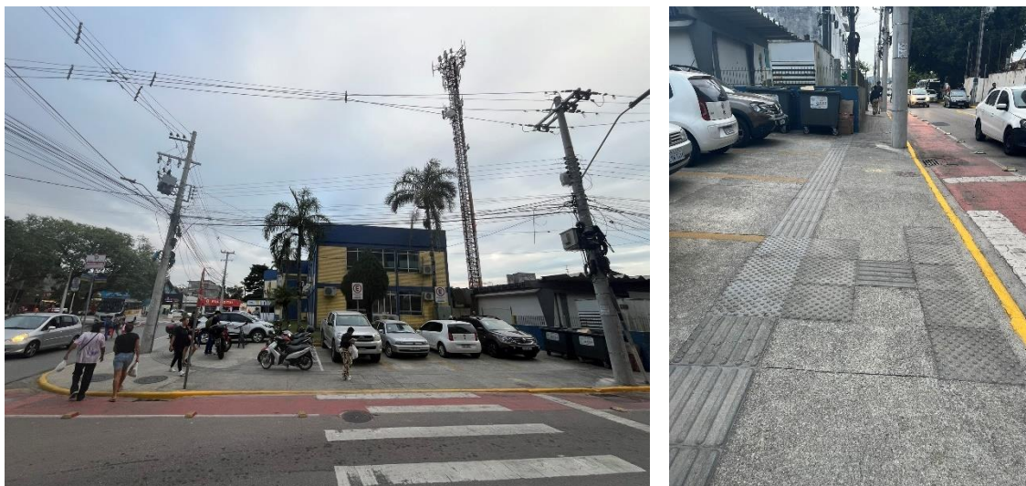
Figura 7 e Figura 8 – Faixa de Pedestres em frente à Rua Hermógenes Prazeres.
