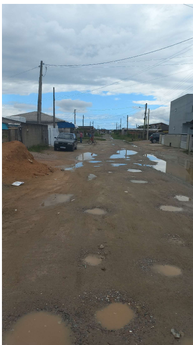
Foto 3: Aspecto geral final da via.
