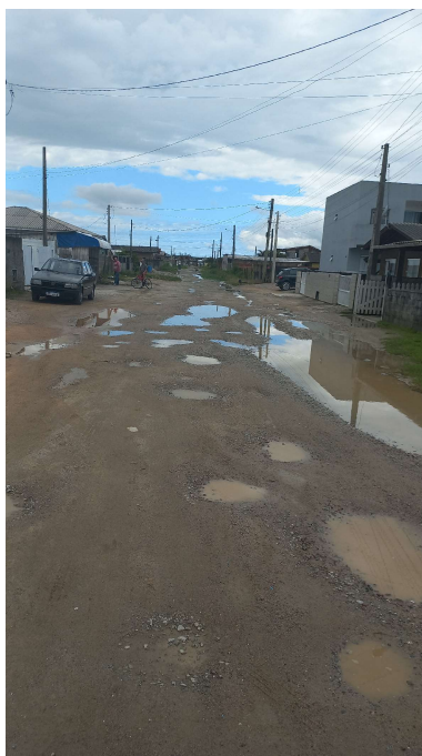
Foto 2: Aspecto geral da via.
