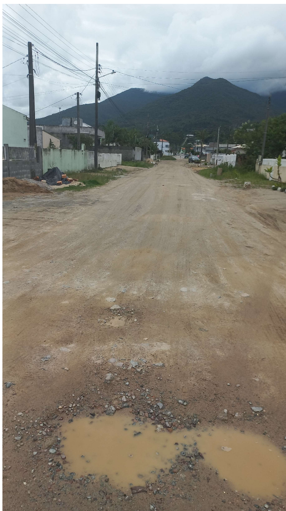
Foto 1: Aspecto geral da via.
