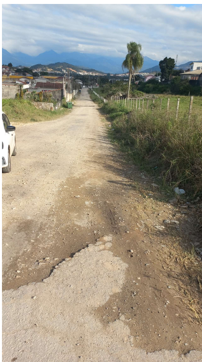
Foto 2: Aspecto geral da via (trecho sem pavimentação).
