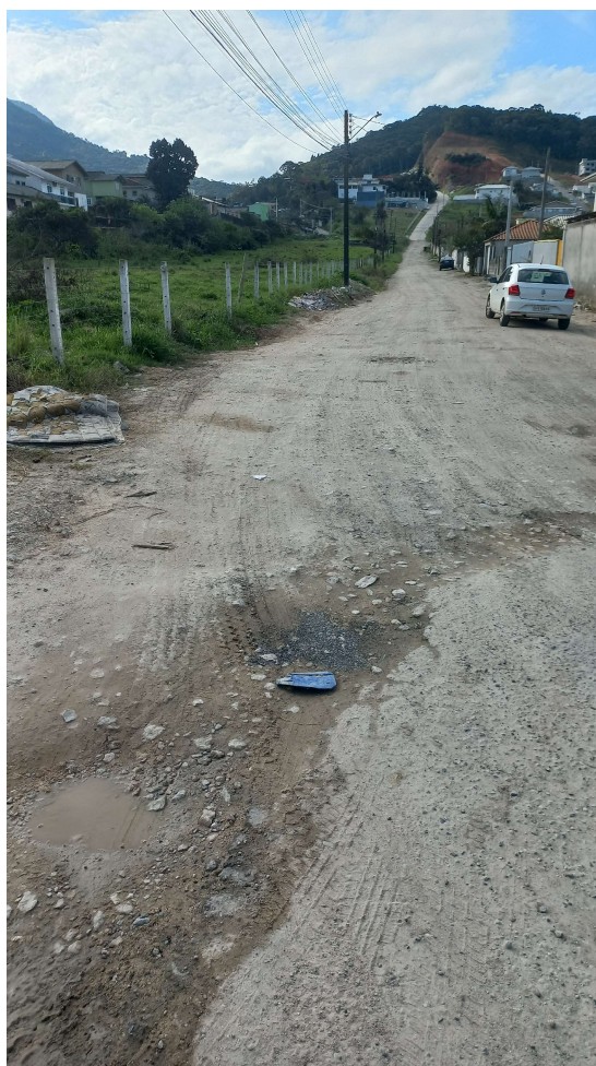
Foto 1: Aspecto geral da via (trecho sem pavimentação).
