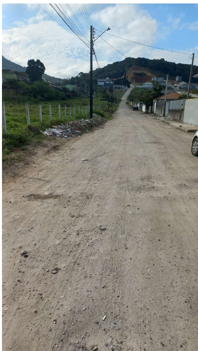
Foto 03: Aspecto geral da via (trecho sem pavimentação).
