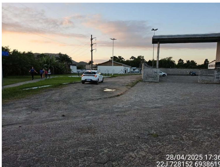
Foto 1: Início da servidão – esquina com a Rua Manoel Joaquim de Souza.
