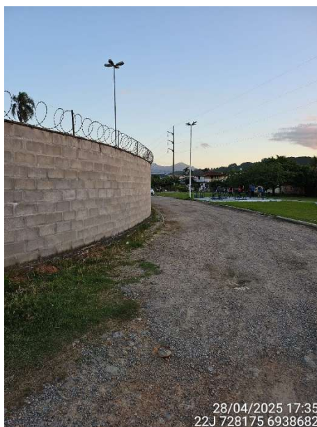
Foto 3: Final da servidão – Vista da Avenida Mário José Mateus.
