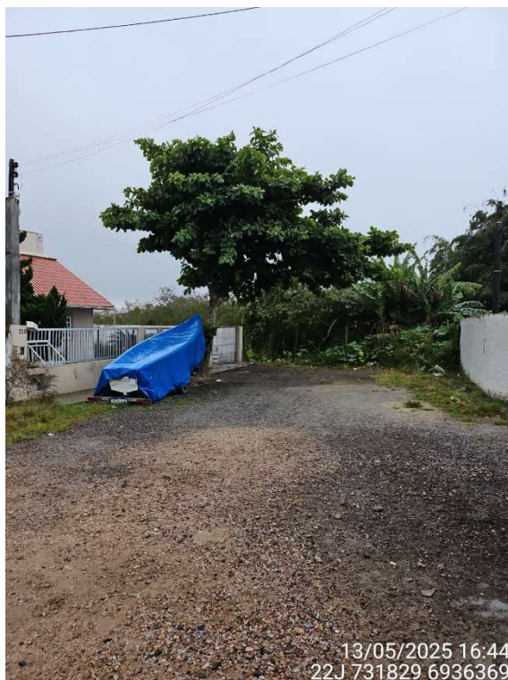
Foto 3: Vista do final da via.
