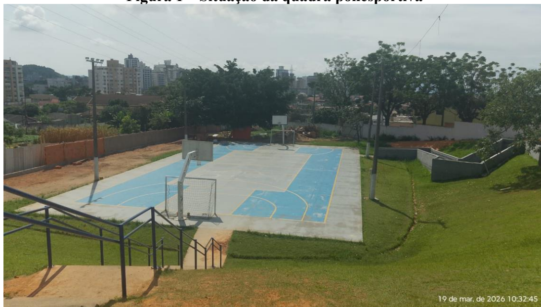
Figura 1 – Situação da quadra poliesportiva
