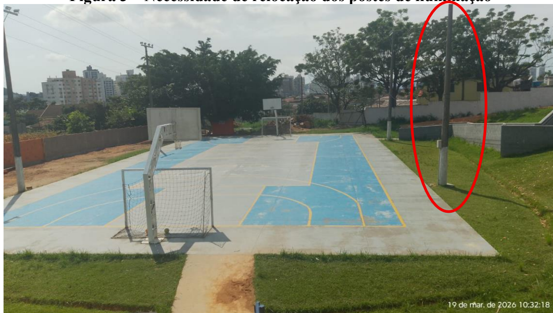
Figura 3 – Necessidade de relocação dos postes de iluminação
