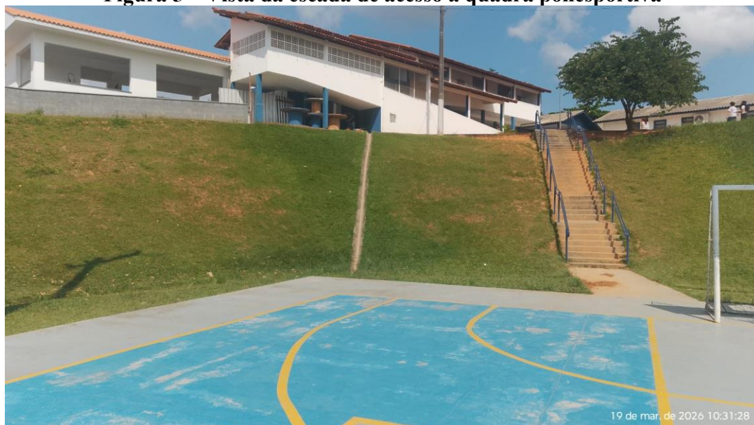
Figura 5 – Vista da escada de acesso à quadra poliesportiva
