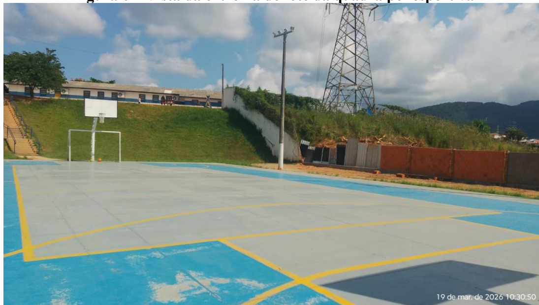
Figura 6 – Vista da extrema do lote da quadra poliesportiva
