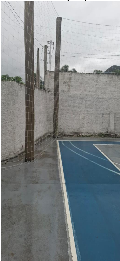
Figura 5 – Poste que deverá ser removido para posicionamento do pilar metálico
