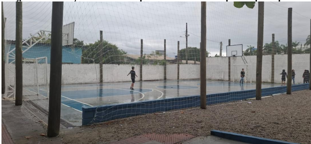
Figura 1 – Situação do local em que será executada a quadra poliesportiva
