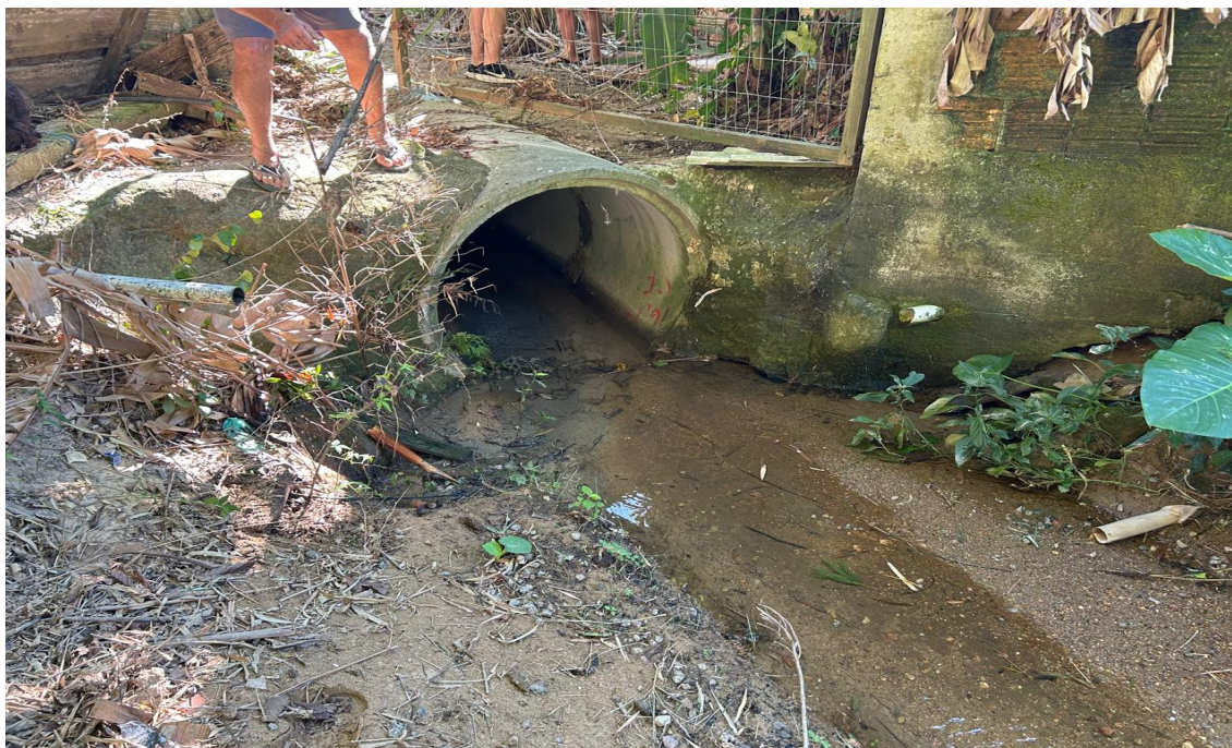
Imagem 04 – Início da transposição, tubo de 800mm atrás de edificação lindeira.
