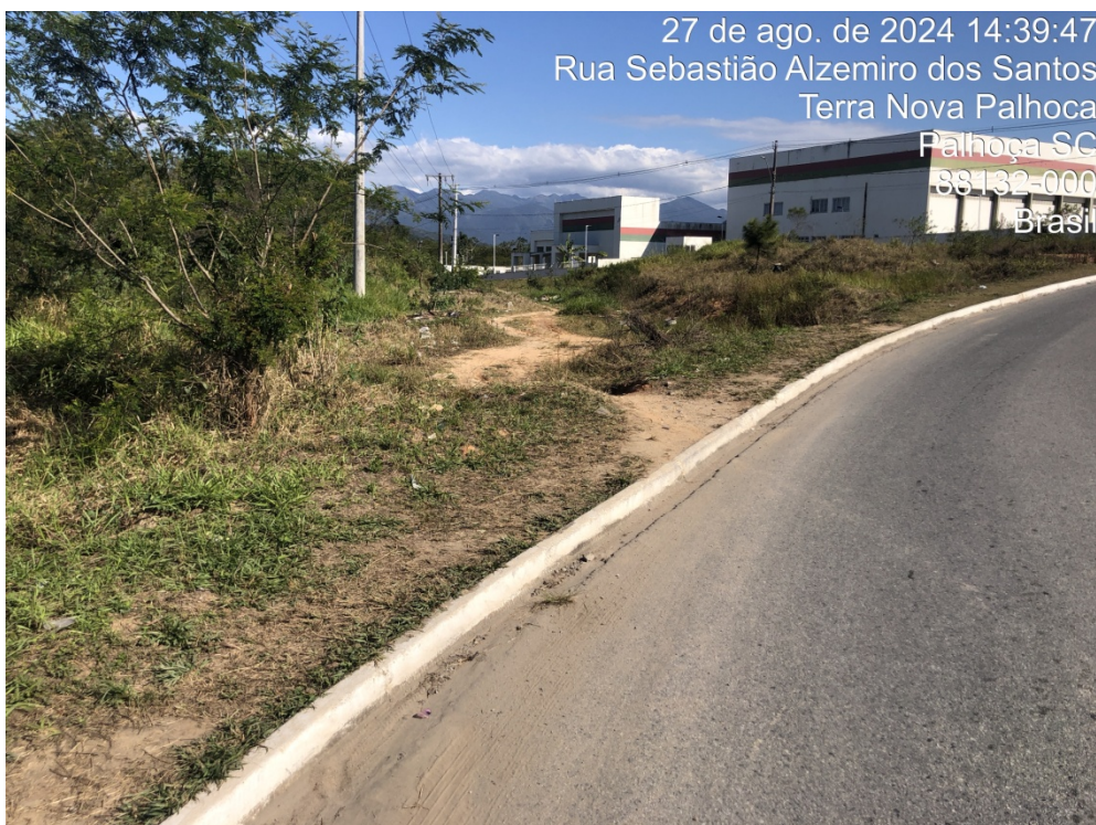
Imagem 8: Vista final do segundo trecho.
