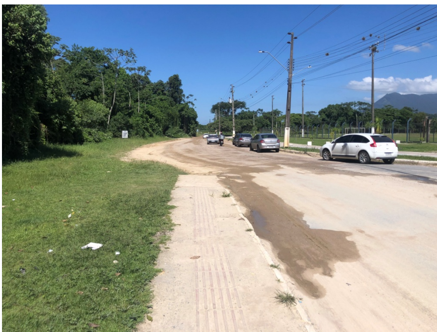
Imagem 2: Trecho final do pav. existente e início da rua.
