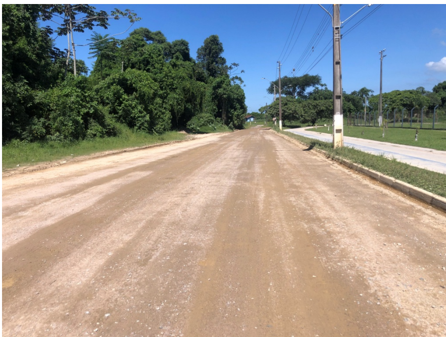
Imagem 1: Vista da rua px. ao campo de futebol.
