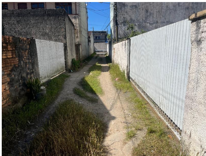
Foto 5: Aspecto geral da via.
