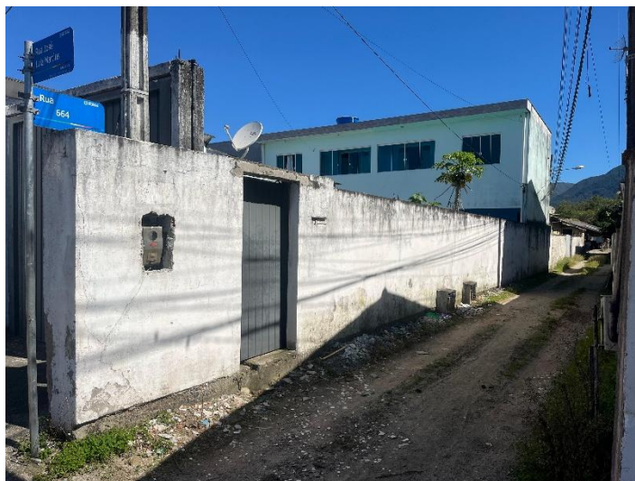
Foto 4: Aspecto geral da via.
