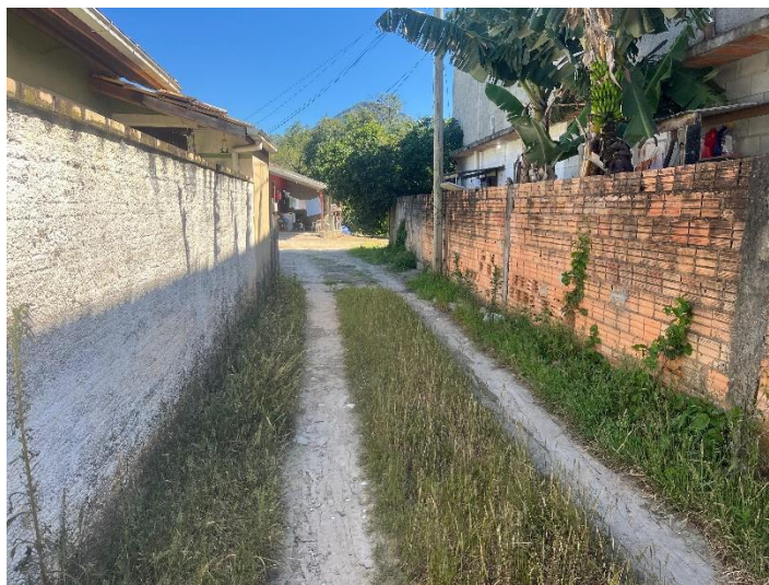
Foto 7: Aspecto geral da via.
