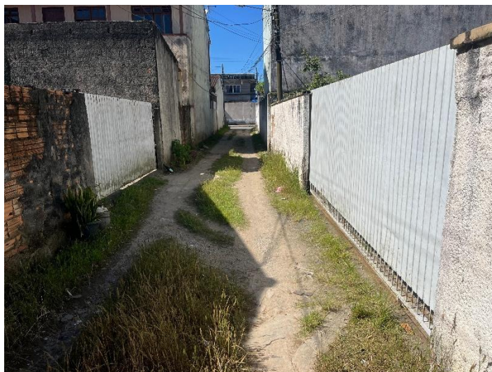
Foto 6: Aspecto geral da via.
