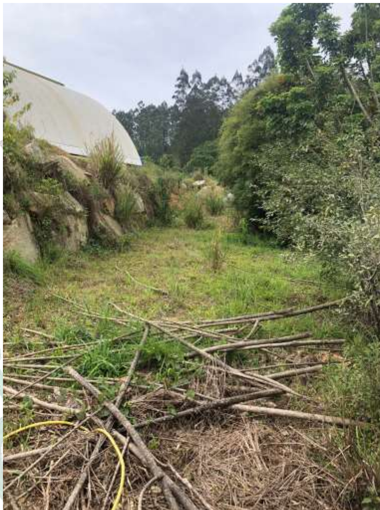
Foto 03: Local onde será realizado o Muro de Contenção.
