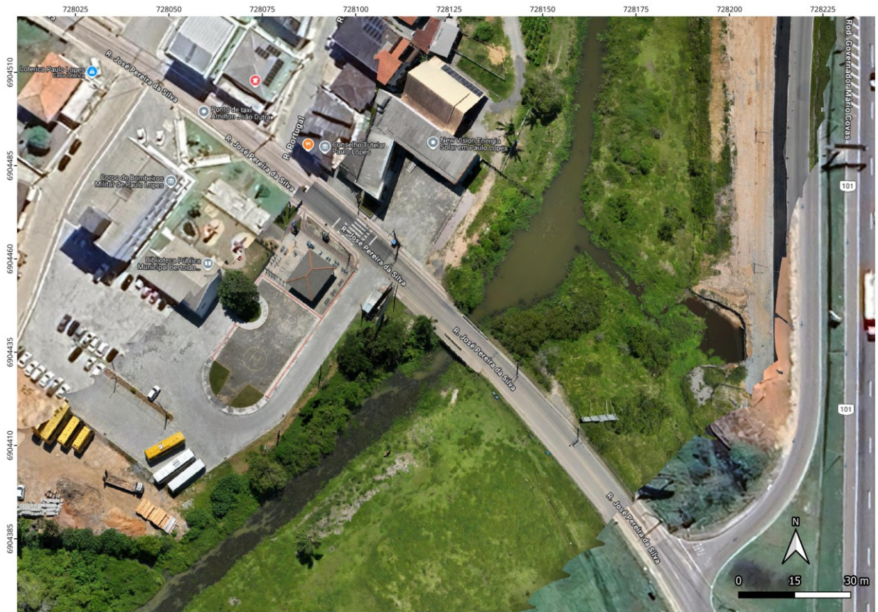
Figura 12. Estrutura de travessia localizada na Rua José Pereira da Silva. Datum: SIRGAS2000 UTM Zona 22S.
